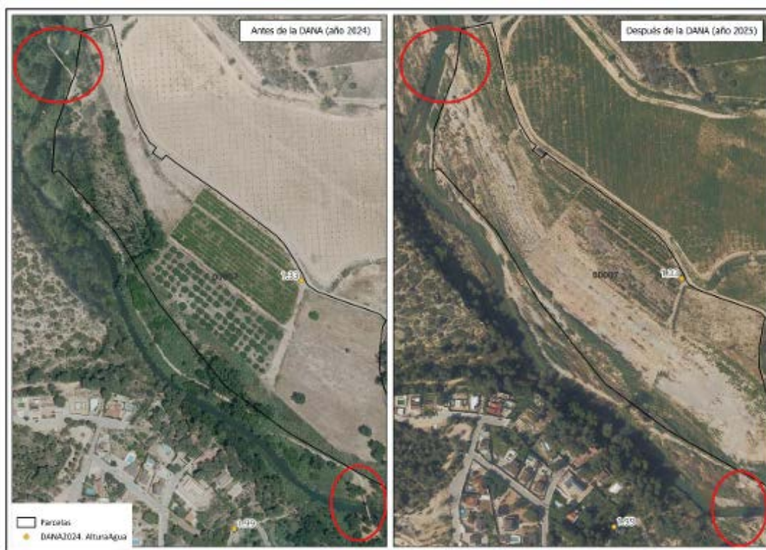
Pasarelas eliminadas del Parque Fluvial del Turia en el ámbito de análisis.
