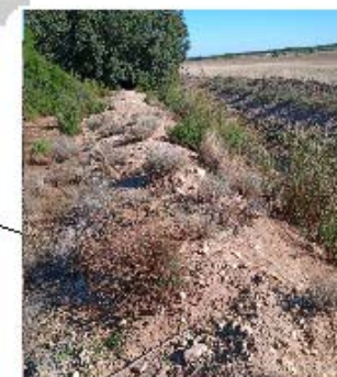
Mota de defensa de inundaciones, construida en tierra sin revestir, ubicada en el margen del río.
