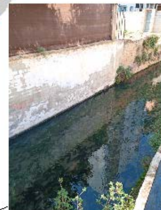
Muro de estabilización de márgenes, construido de roca revestido de hormigón, en buen estado
