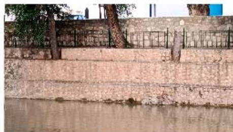
Muro de estabilización de márgenes, construido de roca sin revestir, en buen estado
