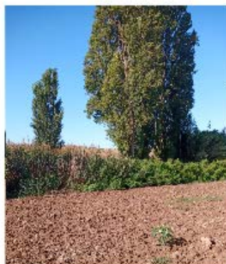
Mota de defensa de inundaciones, construida en tierra sin revestir, ubicada en el margen del río. En estado mejorable
