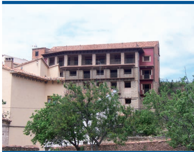
Fábrica de Hilados de Dña Pilar Romero (Mora de Rubielos)
