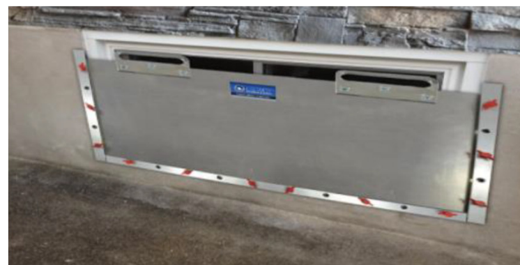
Barreres temporals de finestres i portes
