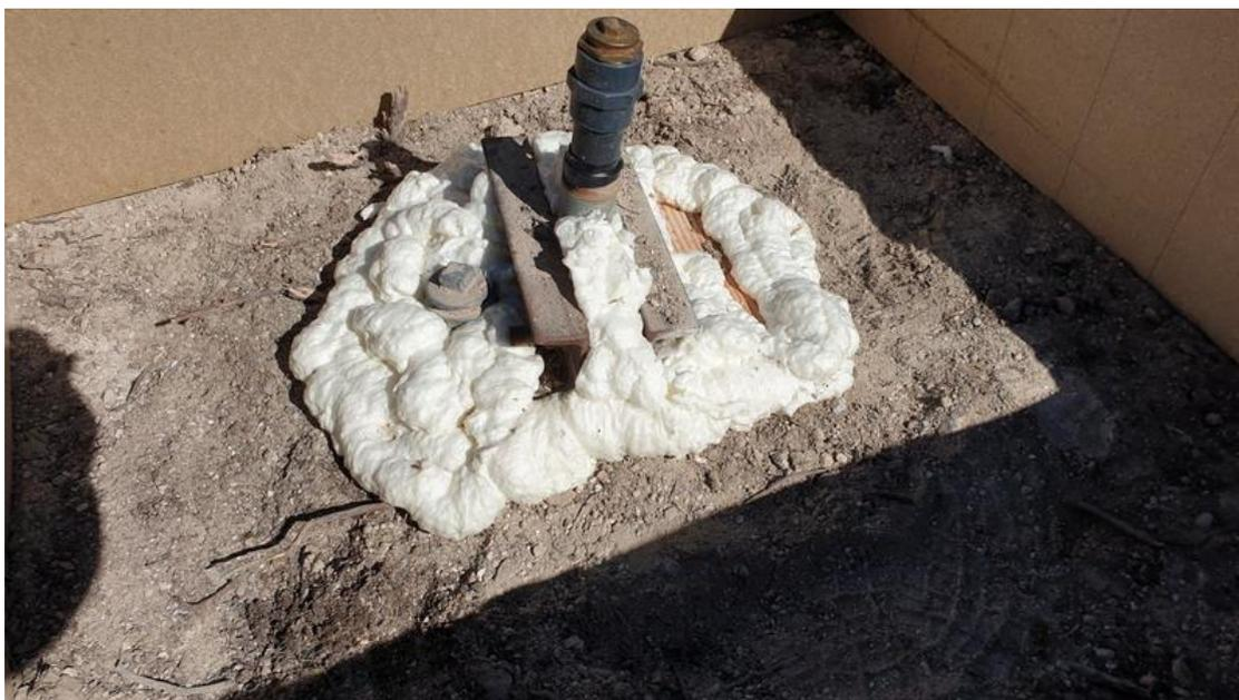
*Ilustración 2.- Detalle aplicación de espuma de poliuretano.*
