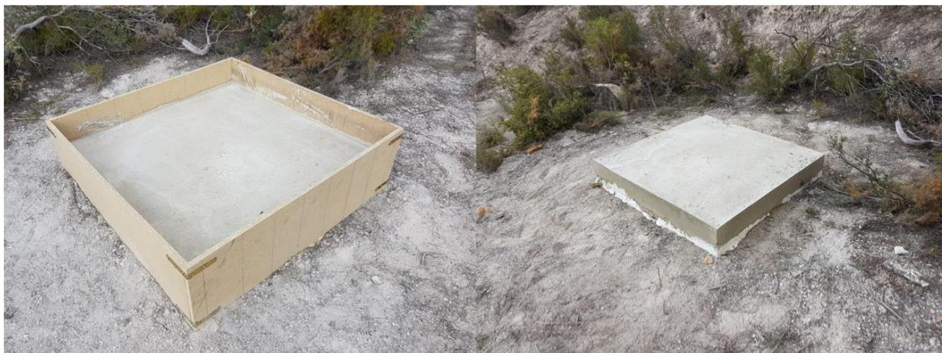
*Ilustración 6.- Detalle finalización losa y retirada de encofrado.*
