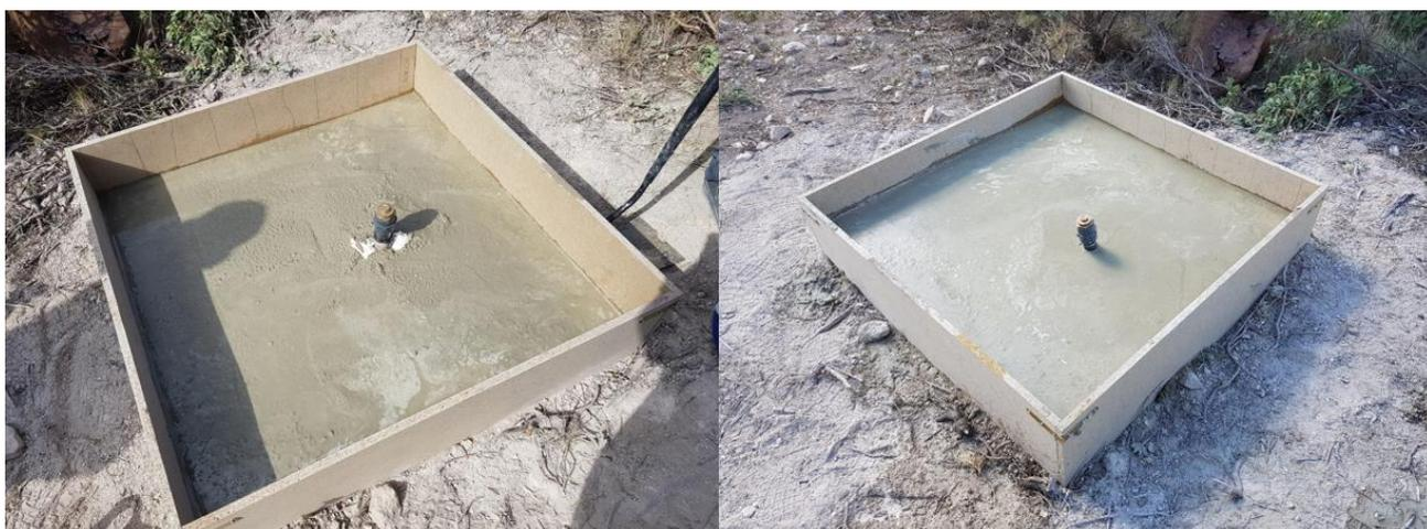
*Ilustración 5.- Vertido de hormigón en el interior del encofrado de la losa.*
