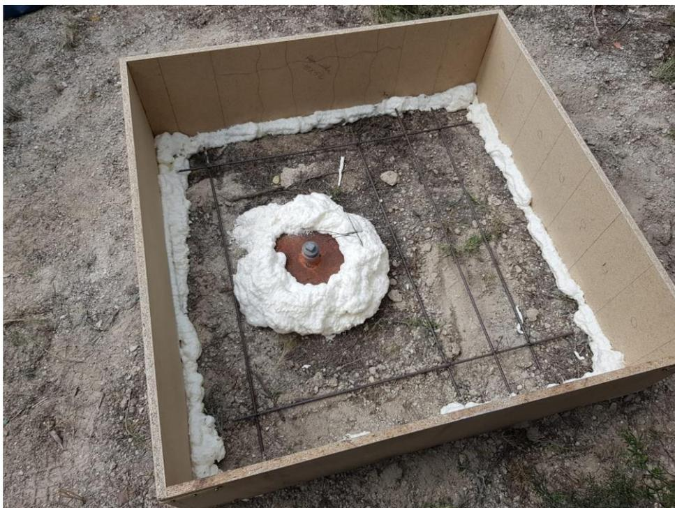
*Ilustración 3.- Detalle adecuación superficie previo vertido del hormigón.*
