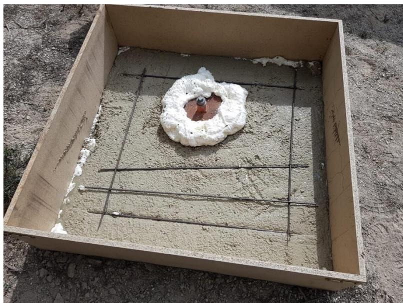
*Ilustración 4.- Inicio vertido de hormigón en la losa.*
