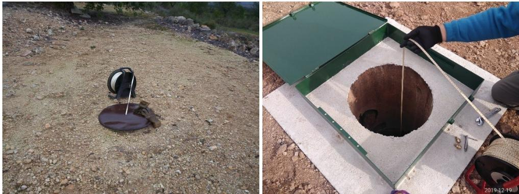
**Piezómetro 08.27.096 antes y después de su reparación**
