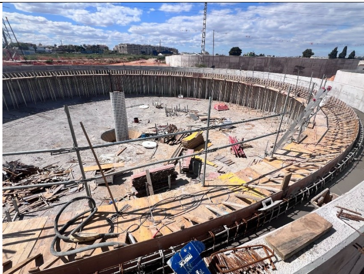
Hormigonado losa canal interior decantador secundario
