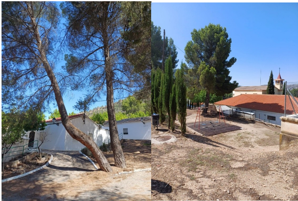
Selección y retirada de pinos con riesgo de caída sobre viviendas en el poblado de Contreras.
