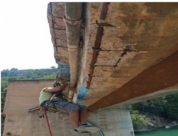
Fotos 4, 5 y 6.- Trabajos de reparación en pasarela sobre aliviadero. Presa de Alcora
