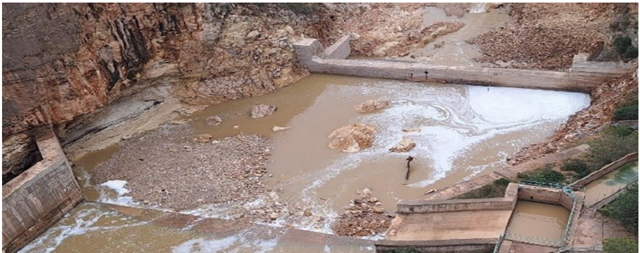
Cuenca amortiguador de la presa Forata
