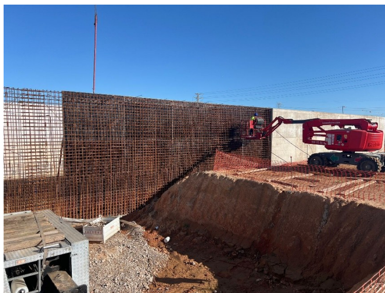
Armado muro recto en reactor biológico
