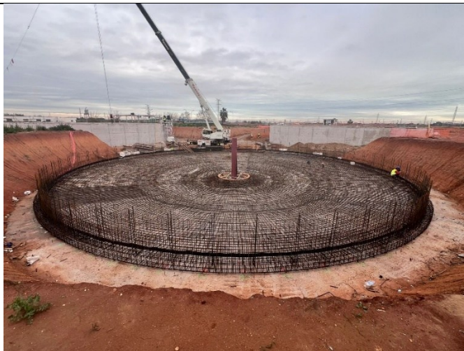
Armado losa decantador secundario nº3
