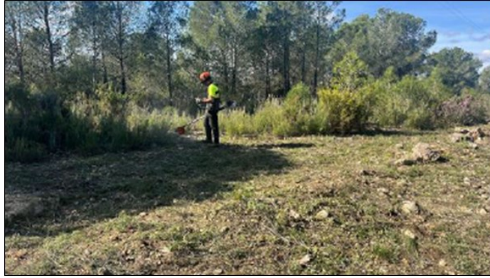
Trabajos de desbroce forestal bajo líneas de alta tensión en la presa de Tous
