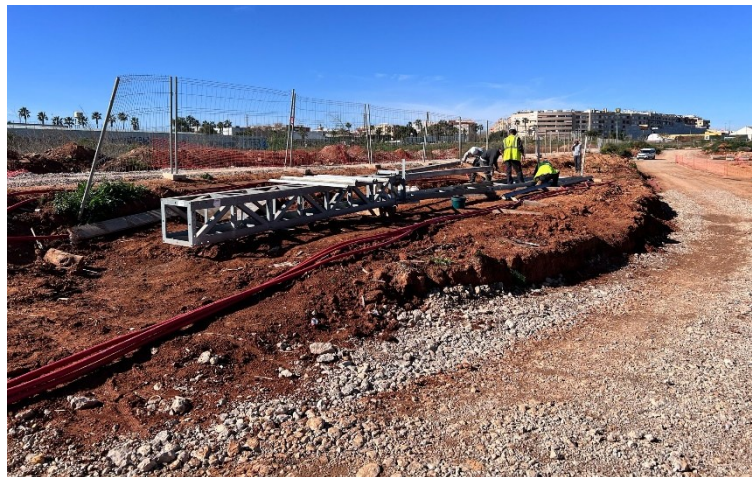
Montaje torre eléctrica
