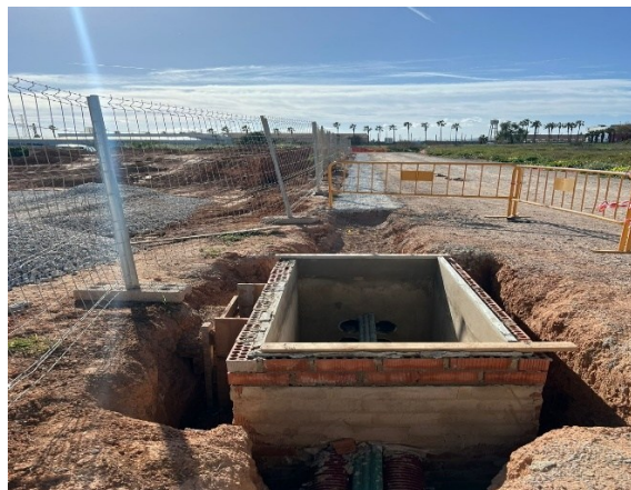
Obra civil línea eléctrica MT enterrada
