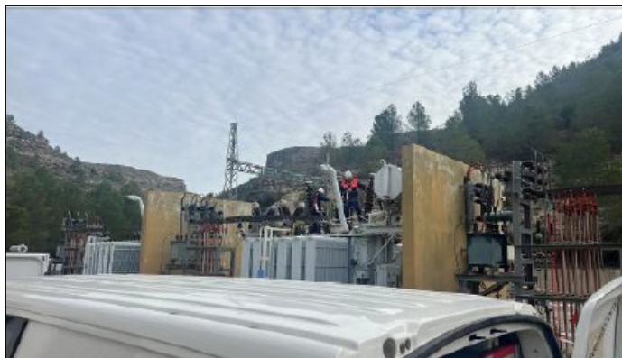
Mantenimiento de subestación eléctrica en la presa de Tous
