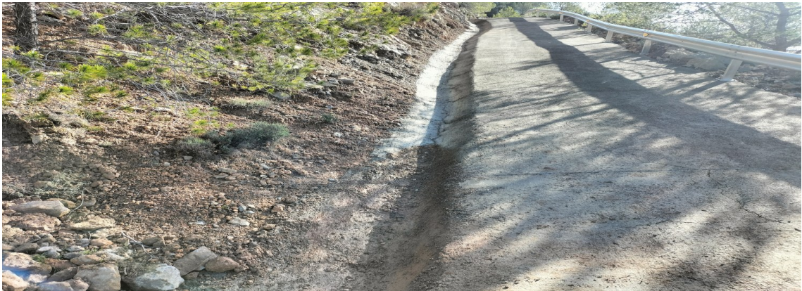
Trabajos de mantenimiento de limpieza de cunetas en camino de acceso a presa
