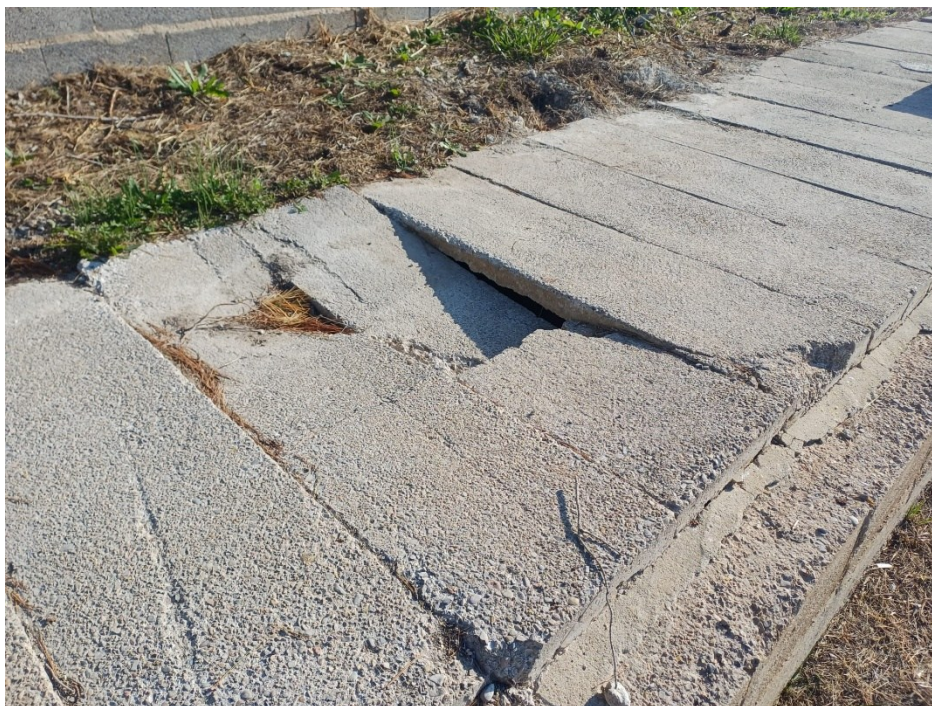
Sustitución de losas rotas para cubrimiento del canal
