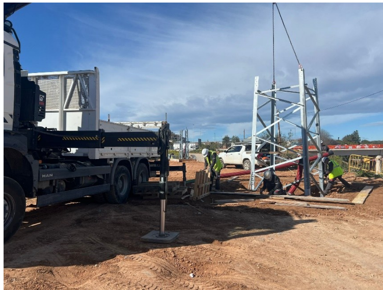
Instalación torre eléctrica Iberdrola
