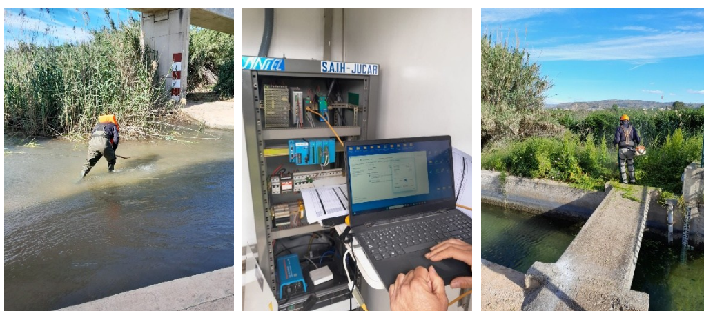
Mantenimiento de las instalaciones
