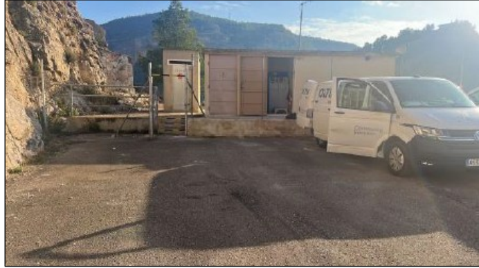
Mantenimiento del centro de transformación y líneas de alta tensión de la presa de Escalona
