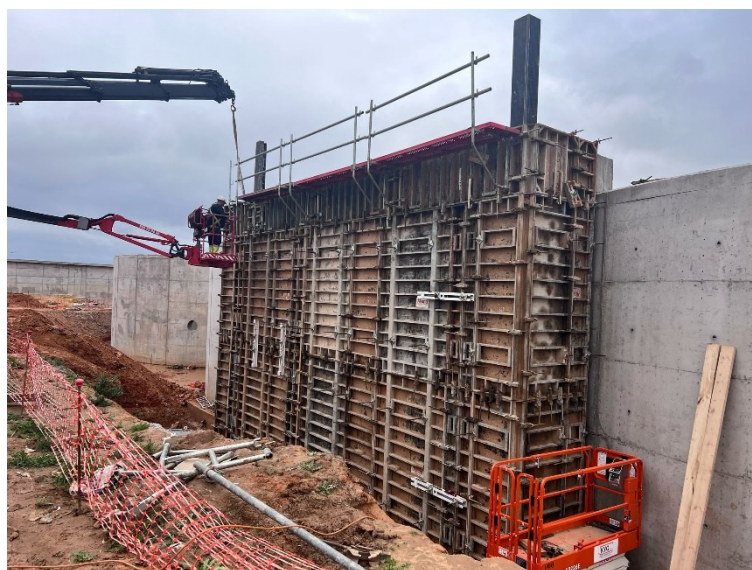
Encofrado muros arqueta de reparto a reactores biológicos
