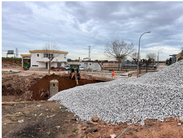
Relleno decantador en EDAR existente
