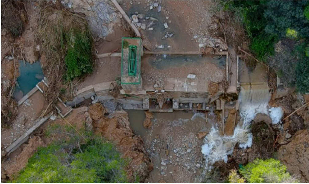
Estado del CCT en Barchel II (PK 2+650)
