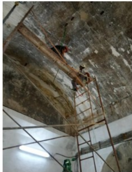
Trabajos de limpieza de paramento de presas y de galerías
