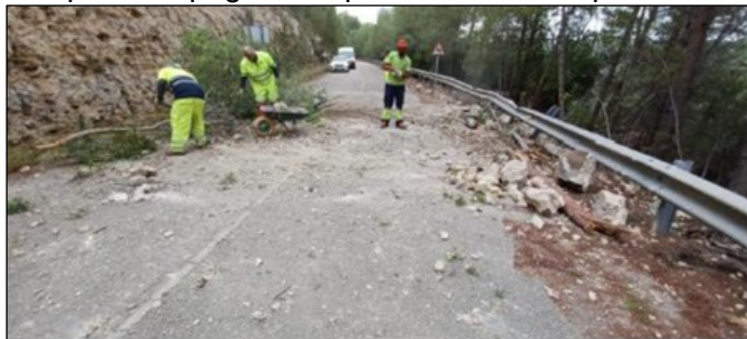
Retirada de material que obstaculizaba el vial por los desprendimientos ocasionados por lluvias, en la carretera de acceso a la presa de Escalona
