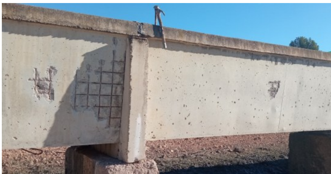
Regeneración de elementos estructurales de hormigón
