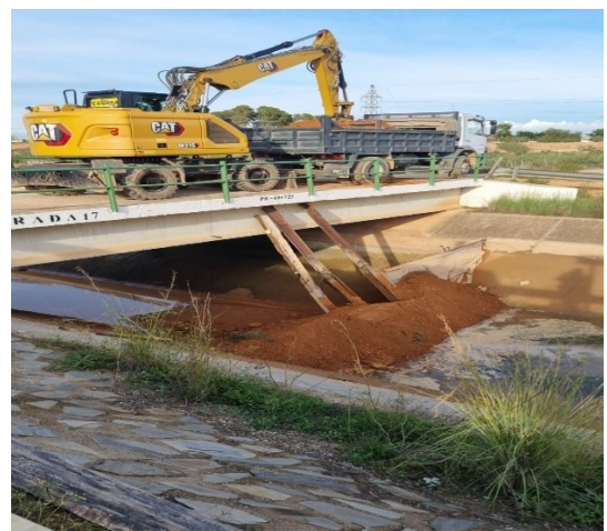
Estado de una de las paradas del canal
