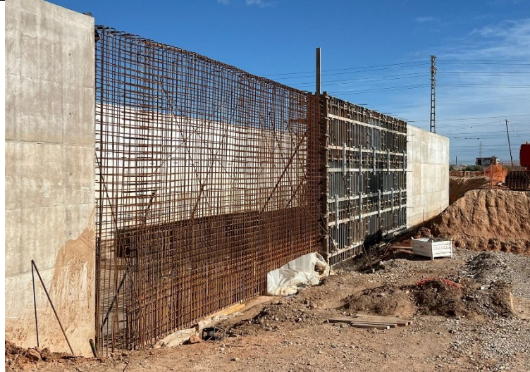
Encofrado muro recto en reactor biológico
