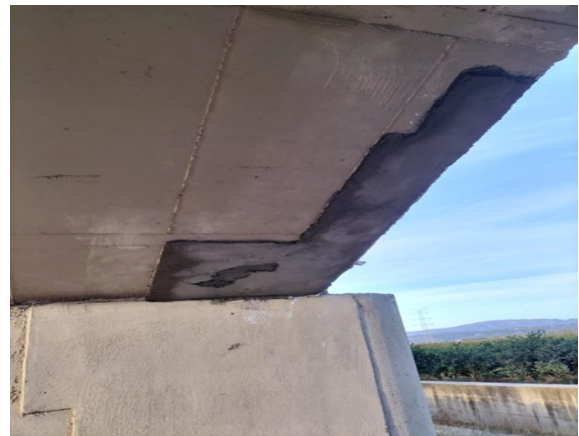
Finalización de los trabajos de mantenimiento correctivo para la reparación de patologías detectadas en el exterior del acueducto nº 7
