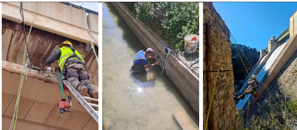
Instalación de sensores del SAIH
