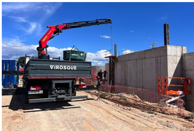
Muros arqueta de reparto a reactores biológicos
