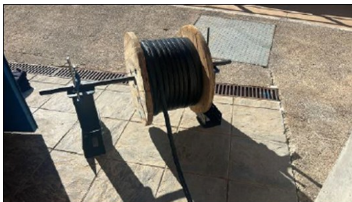
Instalación de cableado específico de comunicaciones por motivos de seguridad en ascensores de la presa de Tous
