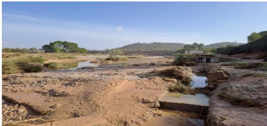
Estación de aforos 93 en Macastre.
