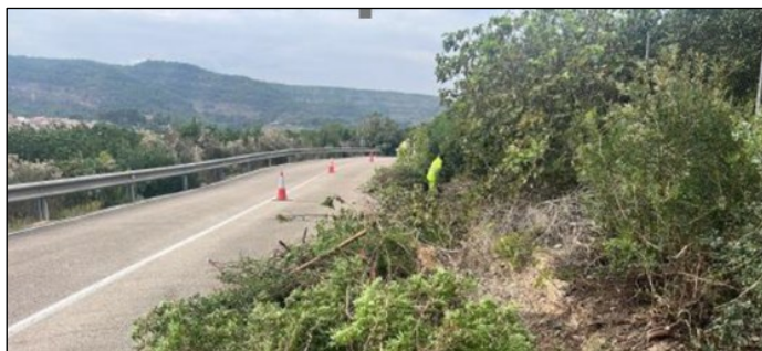
Limpieza de cunetas y viales de acceso a la presa de Escalona
