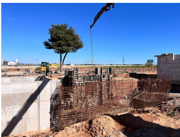
Retirada encofrados en pretratamiento
