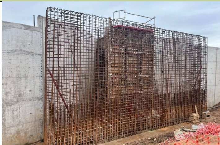
Muros arqueta de reparto a reactores biológicos
