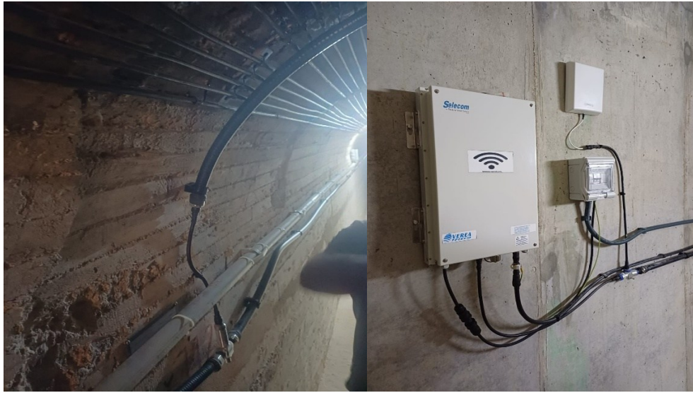
Instalación y puesta en servicio de las comunicaciones en el interior del dique del Collado.
