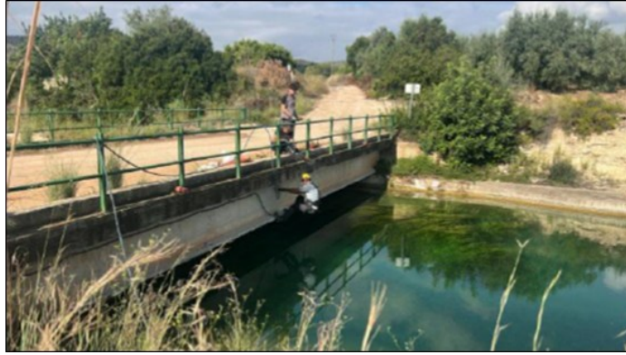
Sustitución de la cámara de la obra y vertido del canal Júcar-Turía para su visualización en la presa de Tous
