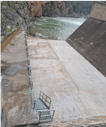
Fotos 1 y 2- Mejora acceso puntos de auscultación y ejecución de solera pie de presa MI. Presa de Sichar. Foto 3.- Ejecución acceso a galería muro de cierre antiguo aliviadero. Presa de Mª Cristina
