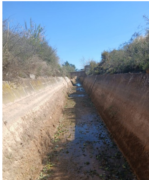
Limpieza interior del canal
