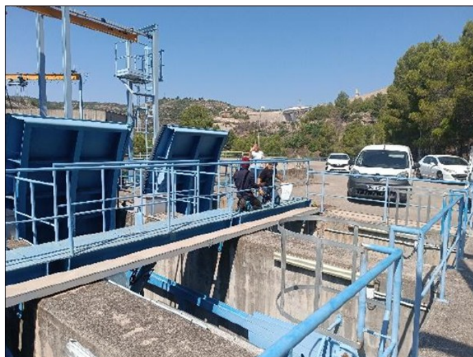
Reparación de compuerta Taintor de la salida del estanque de regulación al Canal Júcar-Turia de la presa de Tous
