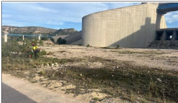
Limpieza de caminos y desbroce en la presa de Tous
