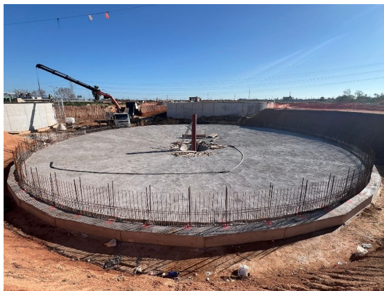
Hormigonado losa decantador secundario nº3
