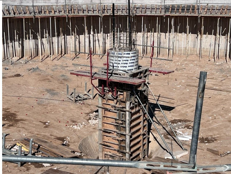
Pilar interior decantador secundario
