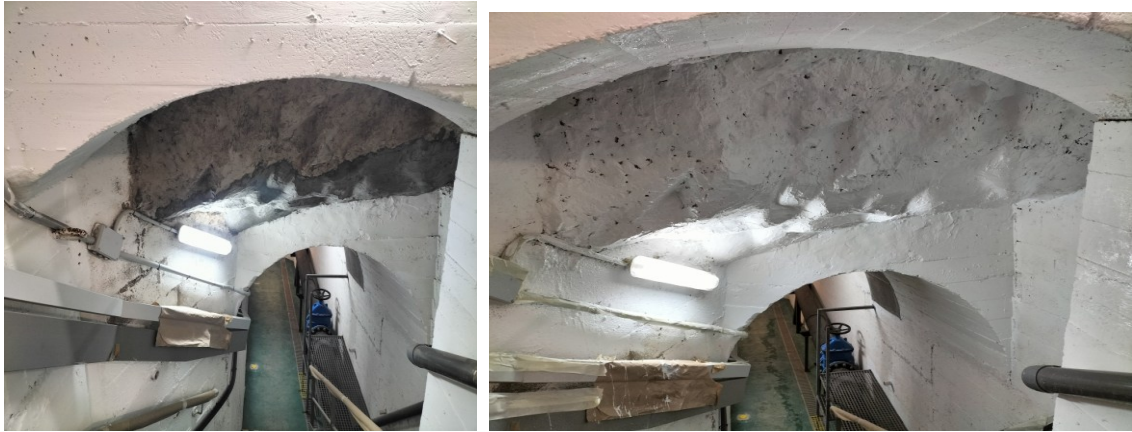
Trabajos de mantenimiento en las galerías de la presa de Arenós.
