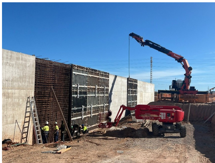
Ejecución muro recto en reactor biológico
