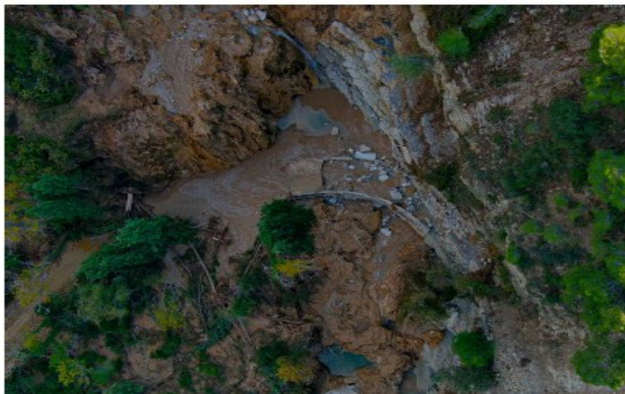
Camino de servicio del CCT interrumpido por derrumbes.
