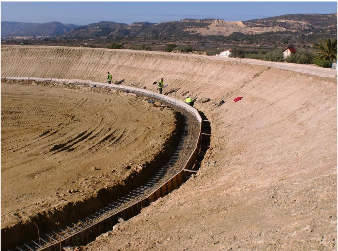
**Balsa en tierra y detalle de zona de anclaje de la impermeabilización de taludes**
