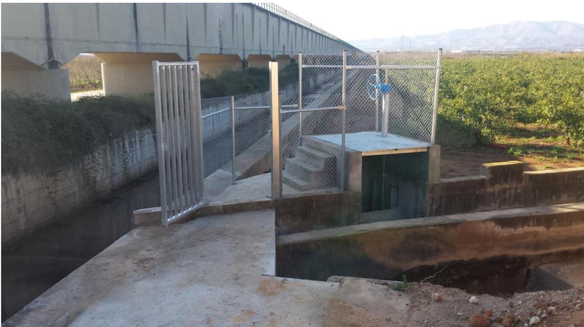
**Arqueta de rotura de carga de la tubería de Frares con compuerta mural junto al derramador.**
