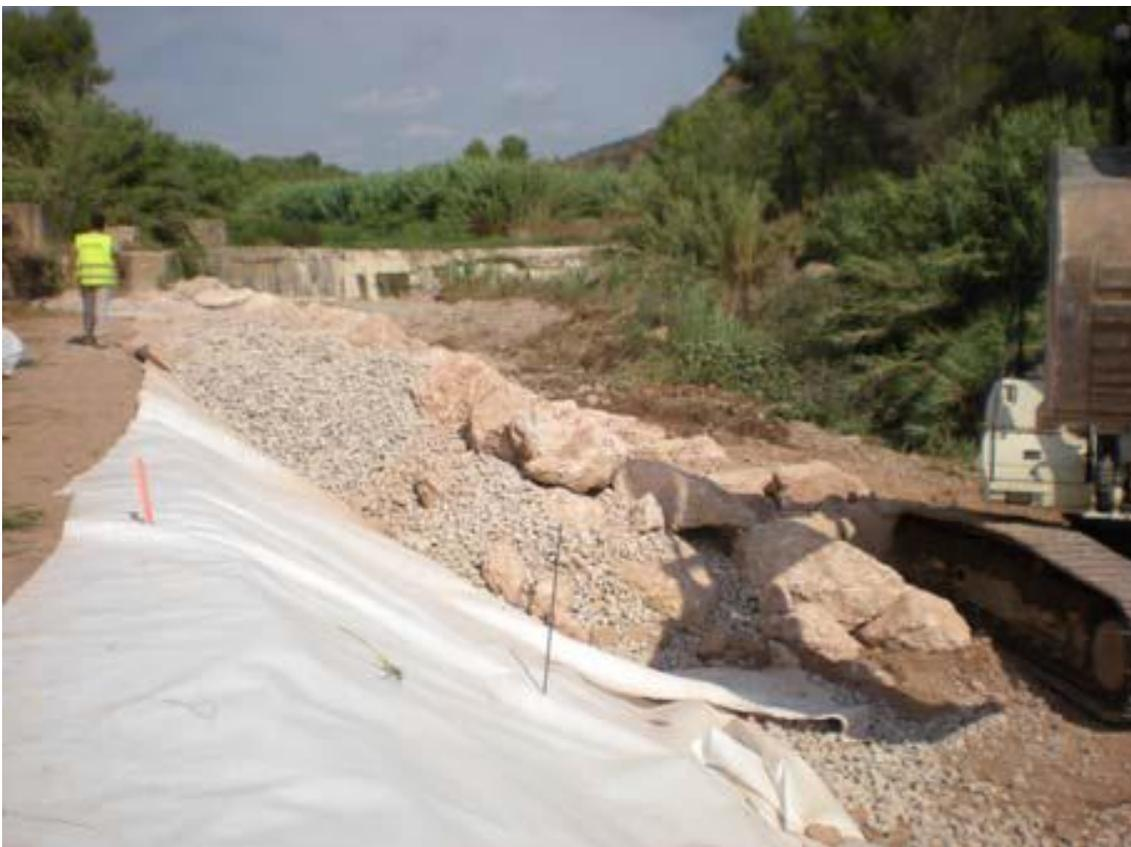
**Protección por medio de geotextil, material filtro y escollera.**
