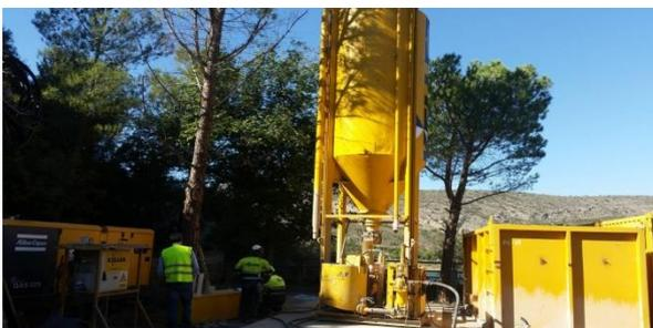
Instalación de los silos de cemento y de la mezcladora de la lechada de inyección.
