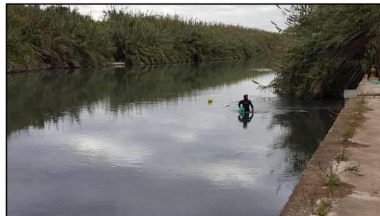
Colocación de cabos entre sensores como referencia de las alineaciones a limpiar
