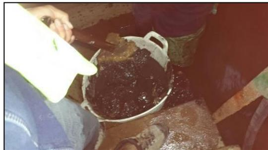
Limpieza y extracción de barro en poceta, con ciclos alternos de entrada y salida de agua al interior
