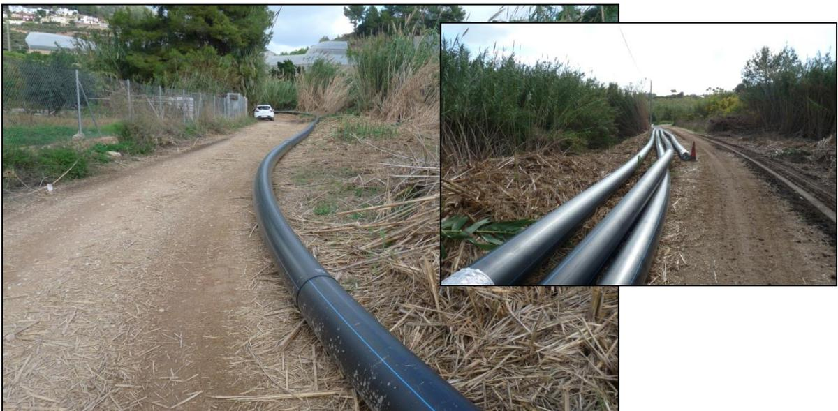
**Tubería PE-100 DN315 PN10 acopiada en camino en espera de ser colocada en zanja.**
