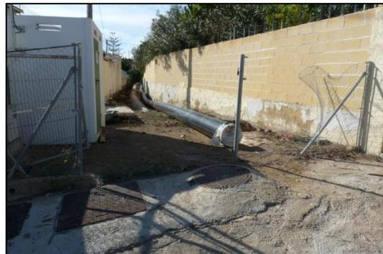
**Montaje de la tubería PE-100 DN400 PN10 sobre el Canal Bajo del Algar en zona urbana**
