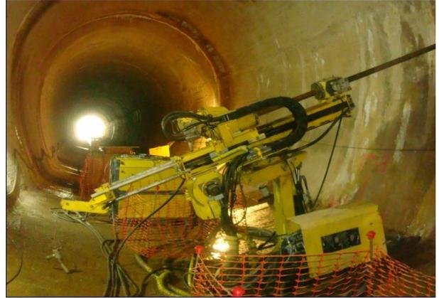
**Trabajos perforación drenes californianos en el interior del túnel de desvío.**
