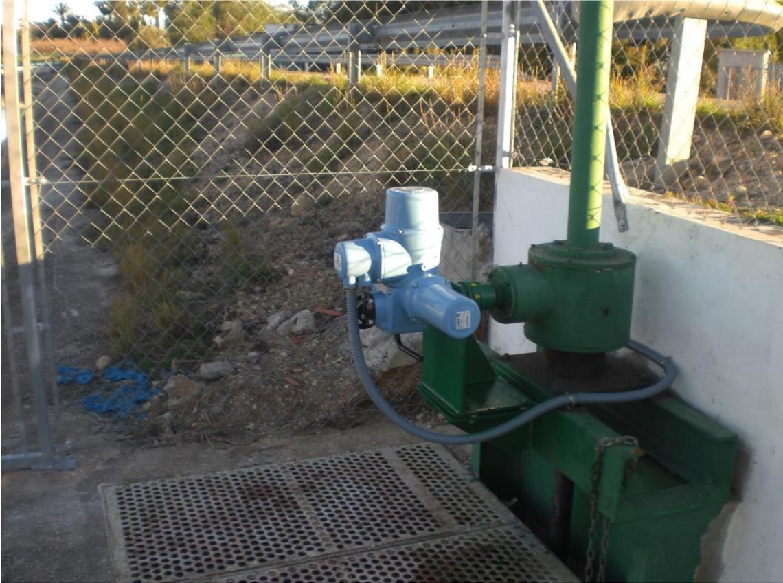
Actuador para motorizar las compuertas de riego
