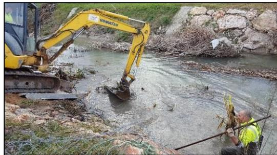
**Extracción y limpieza mecánica de cañas en fondo de cauce con apoyo manual**
