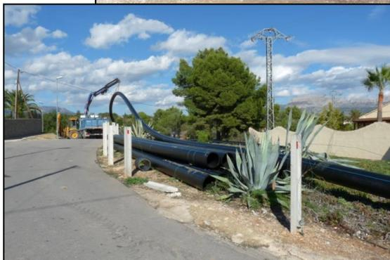
**Montaje de la tubería PE-100 DN400 PN10 sobre el Canal Bajo del Algar en zona rustica**
