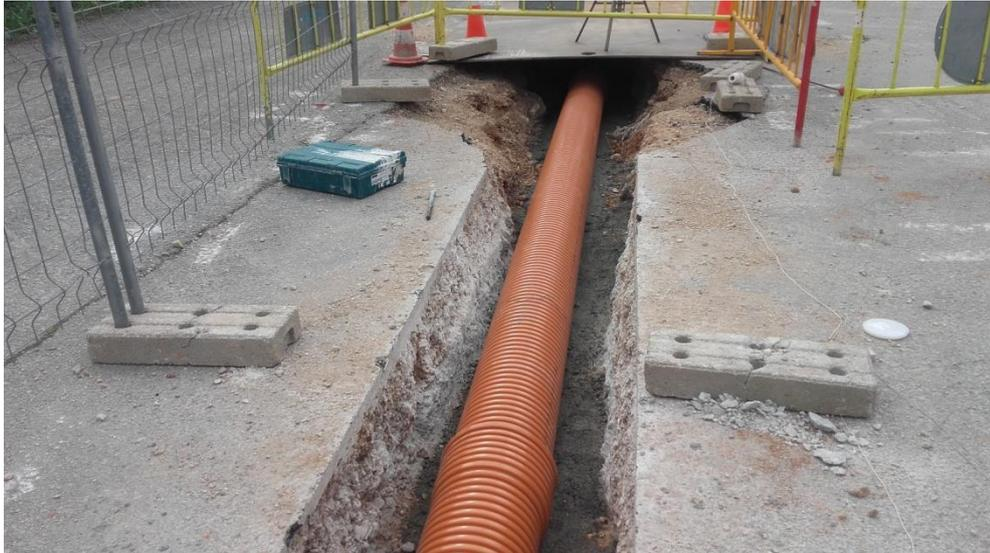
Ejecución de colector en zanja poco profunda. En este caso se rellena de hormigón.
