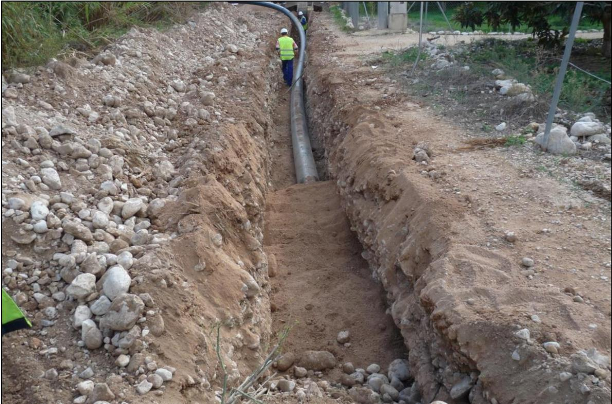
**Montaje de la tubería PE-100 DN315 PN10 en zanja**
