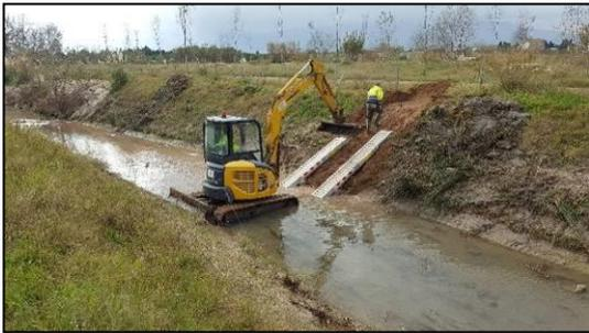
**Acceso de retroexcavadora giratoria de cadenas de goma al interior del canal de margen izquierda**
