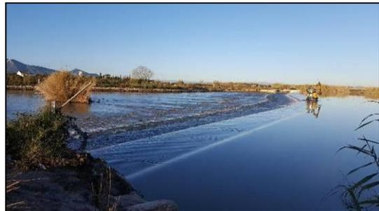
**Desplazamiento de retroexcavadora giratoria de cadenas de goma sobre la coronación del azud**
