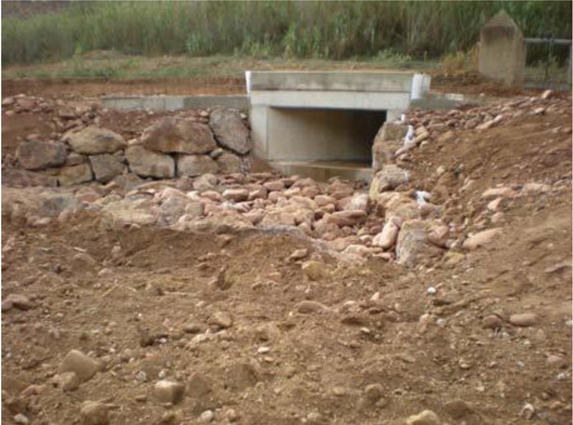
**Obra de fábrica para dar continuidad a la compuerta de la acequia.**
