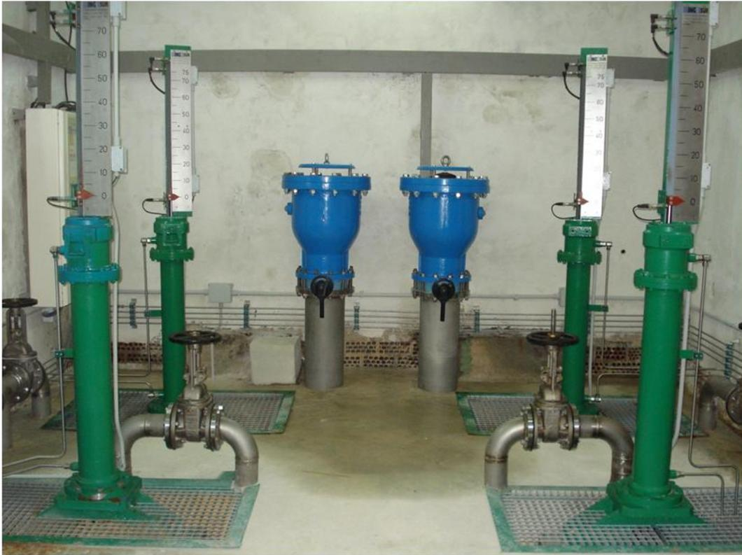
Sustitución y acondicionamiento de los elementos hidráulicos de la toma de agua
