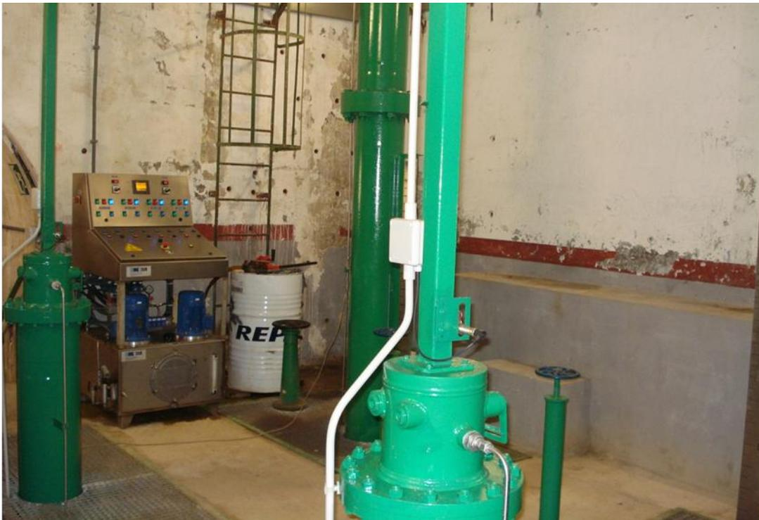
Cámara de desagüe de fondo . En primer término nuevos cilindros de las compuertas de regulación, en 2º término el nuevo pupitre y castillete compuerta seguridad
