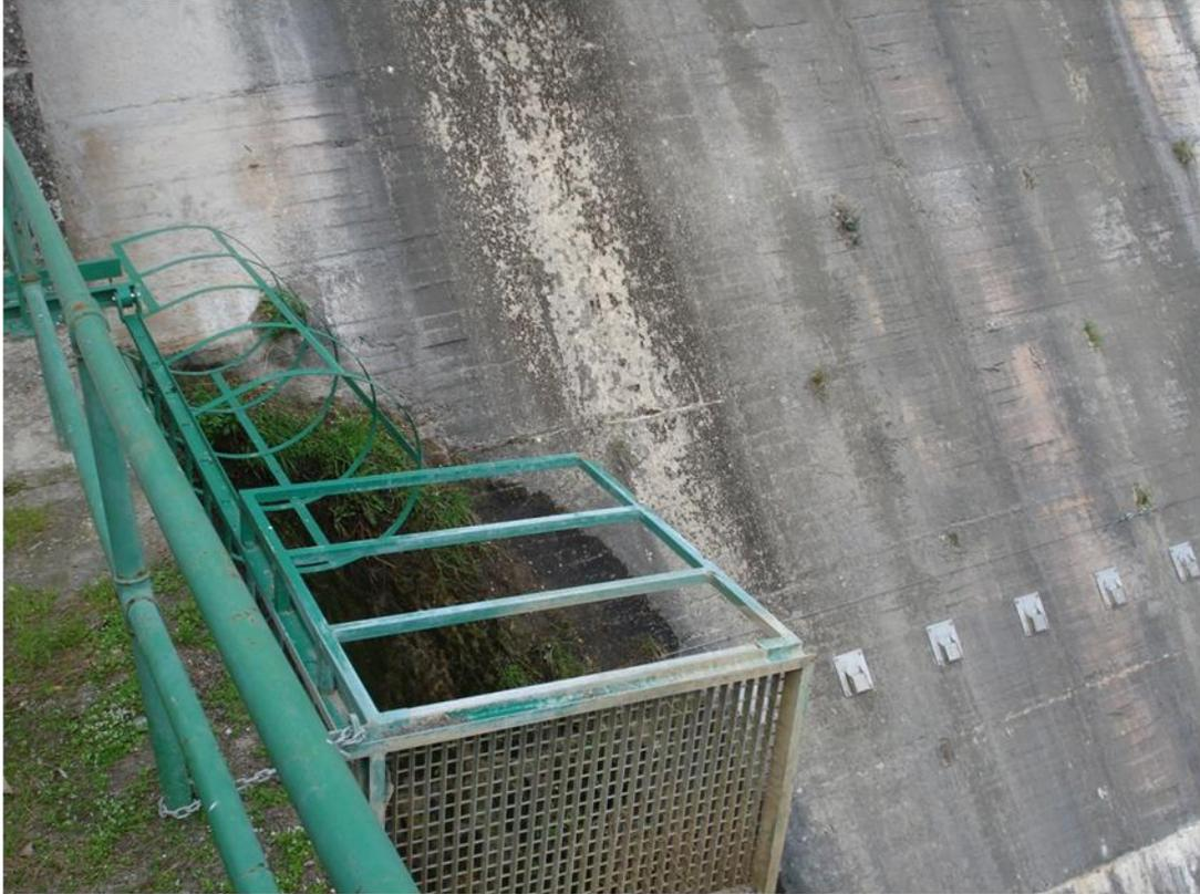
Acceso por el paramento de la presa a los conductos del desagüe de fondo (escalera abatida y recogida y pasarela desmontada por seguridad)
