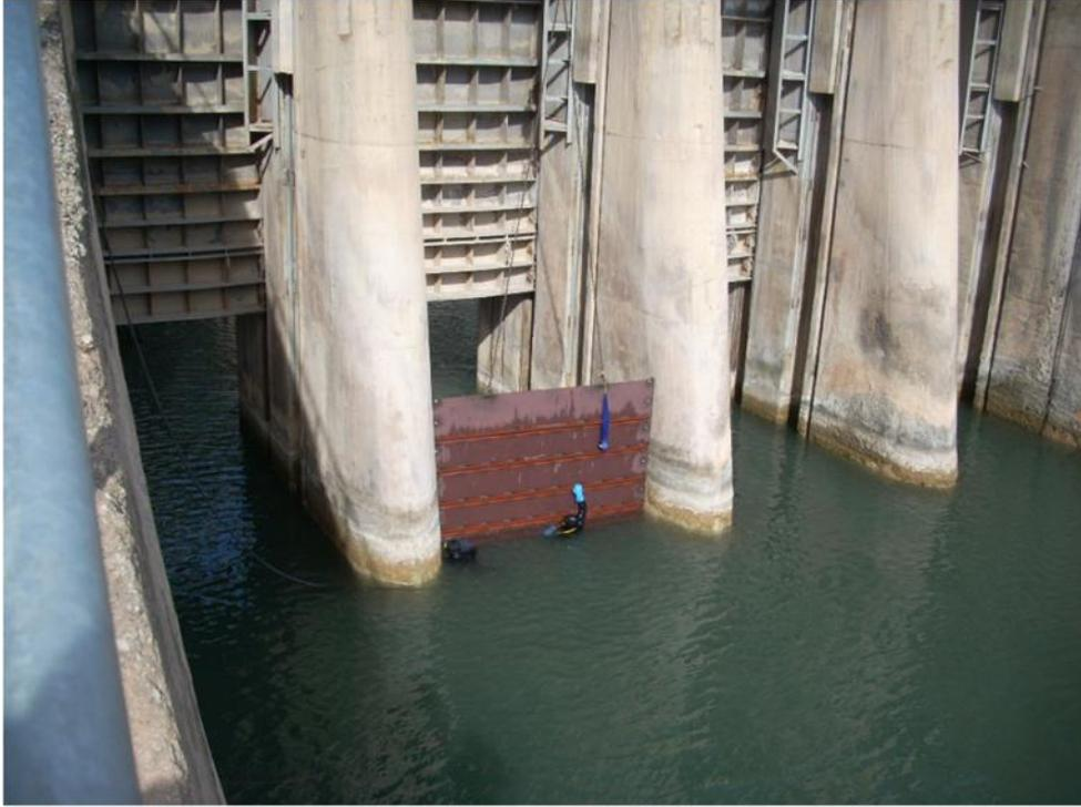
Ataguías colocadas para la reparación de las guías del desagüe de fondo.
