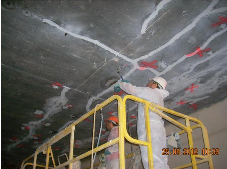
Operarios inyectando resina en el conducto del desagüe intermedio
