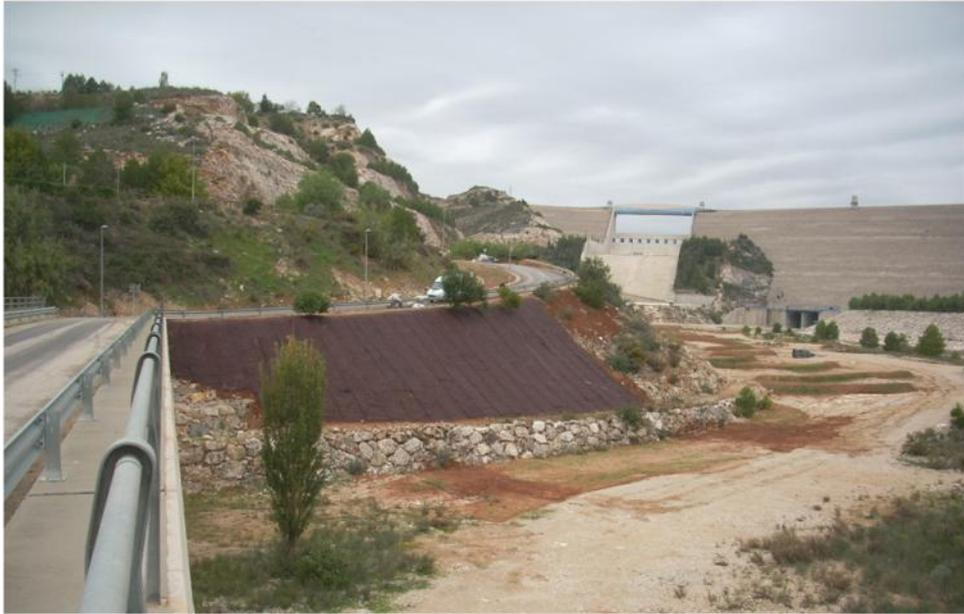
Adecuación ambiental. Colocación de malla trinter en el talud junto al puente de aguas abajo.
