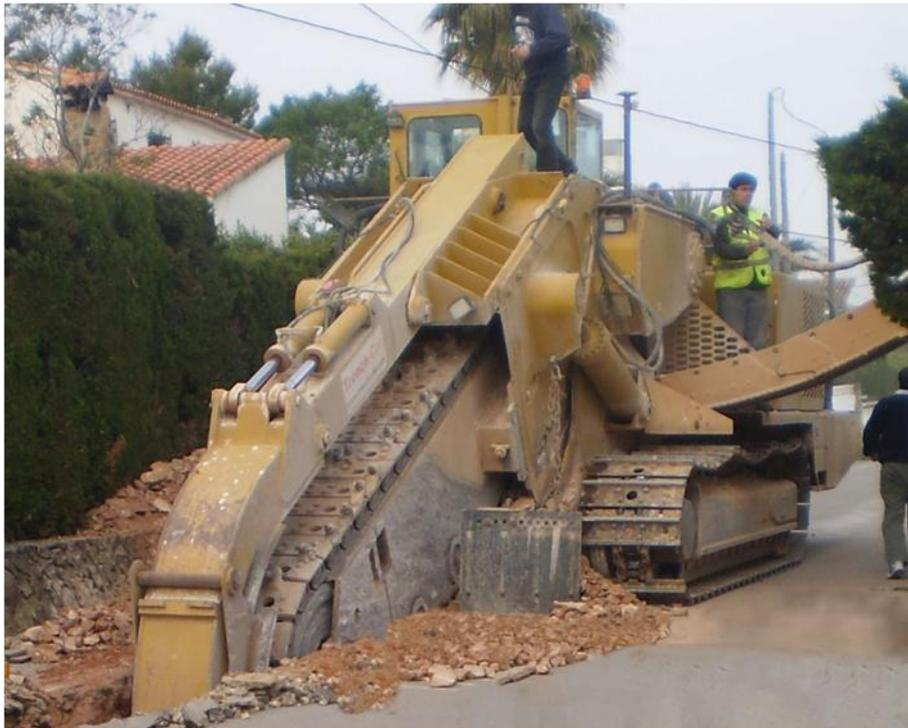
Zanjadora utilizada en apertura de zanja
