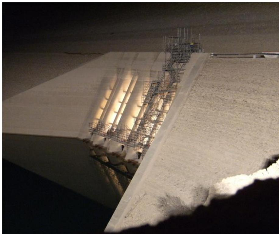
Andamio de acceso al interior de los conductos del desagüe intermedio para reparación de grietas
