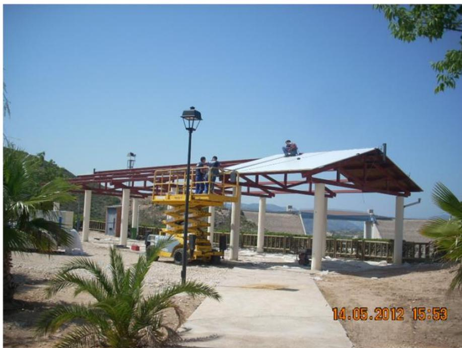
Sustitución de cubierta en las pérgolas. Colocación de panel sándwich con núcleo central de lana de roca en las pérgolas
