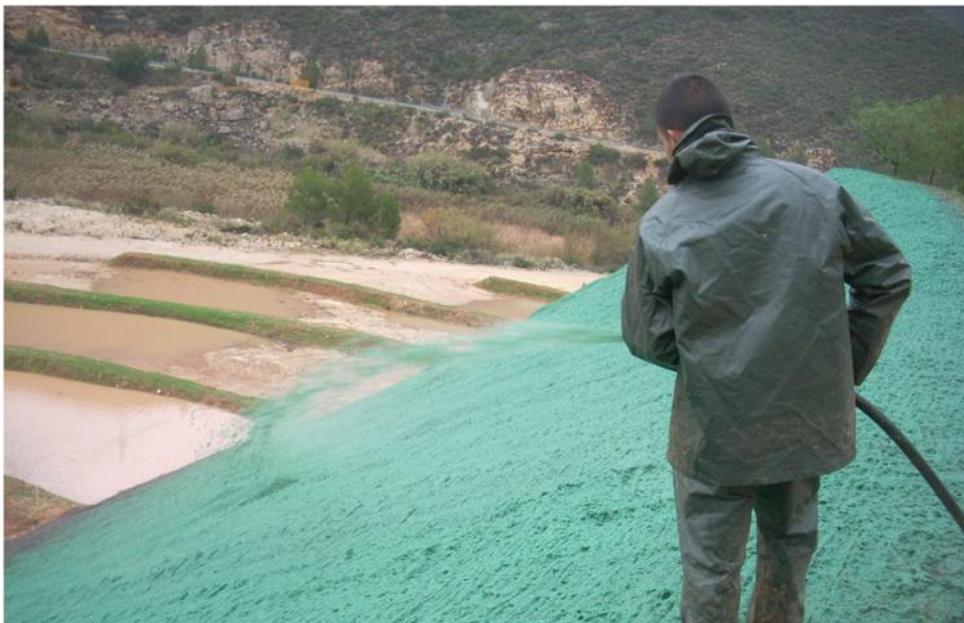
Adecuación ambiental. Hidrosiembra en talud de la margen derecha del río.
