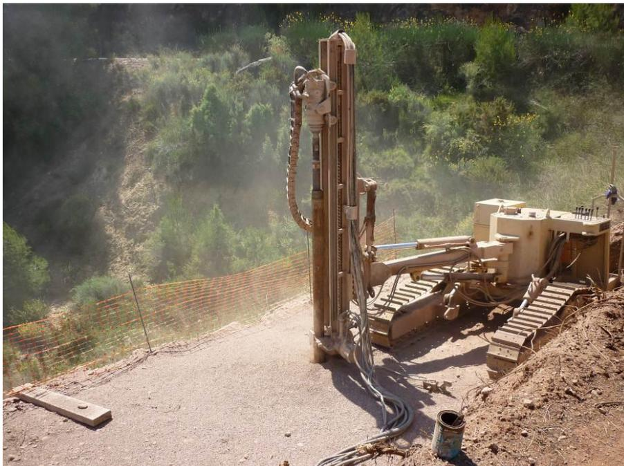
Carro perforador ejecutando un sondeo para la instalación de un inclinómetro en el talud de aguas abajo de la presa.
