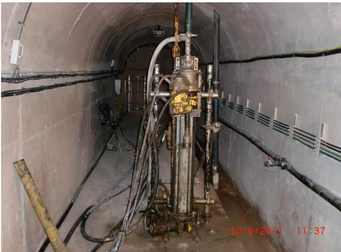
Perforadora en galería realizando el sondeo para la instalación de un piezómetro de cuerda vibrante.
