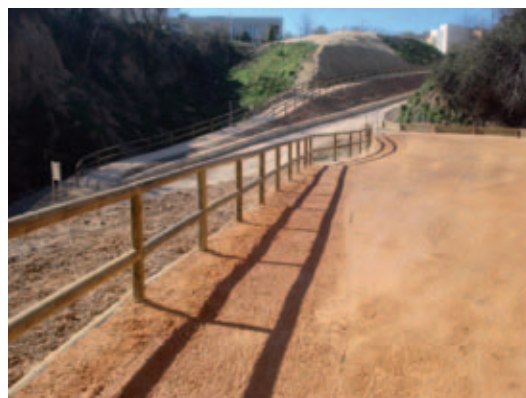
Acondicionamiento del Barranco del Sord en Cocentaina, Alicante.
