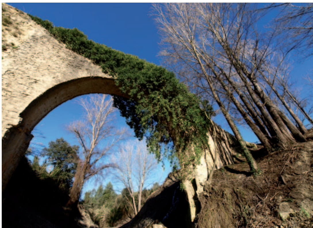
Recuperación barranco de L'Arcà, acueducto del S.XII, en Carrícola (Valencia).
