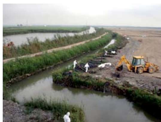
Trabajo de movimiento de tierras para transformar el arrozal del Tancat de la Pipa en una zona de marjal
