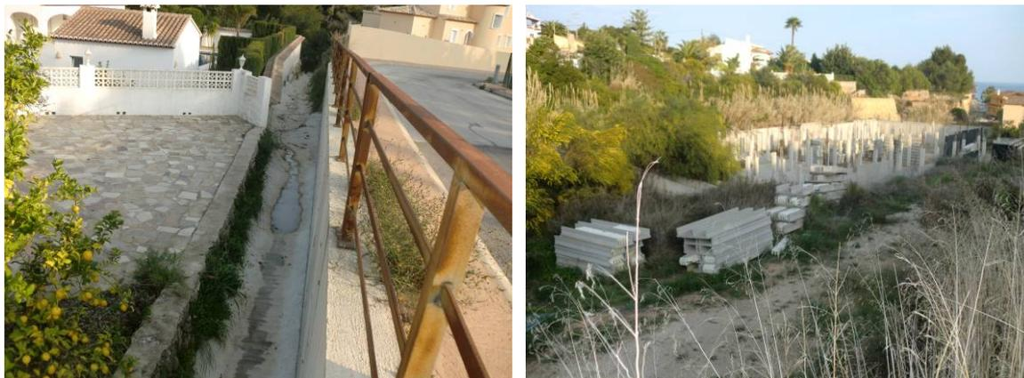
**Fotos 6 y 7: Tramo final del canal a cielo abierto y entrega a barranco. Derecha, materiales y obras paralizadas ocupan la parte media-baja del cauce.**
