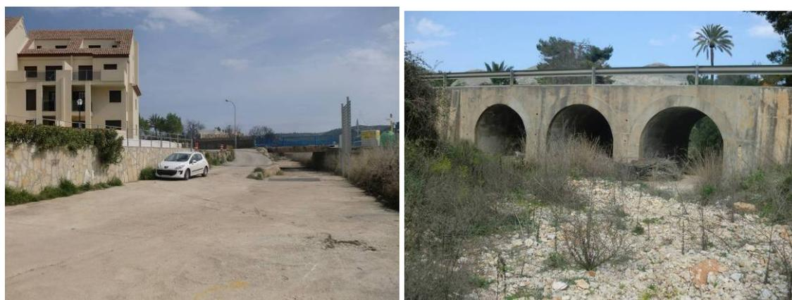
Fotos 32 y 33: Muro a recrecer en 1,5 metros para proteger viviendas anexas al barranco del Cau en Líber. A la derecha puente sobre barranco de Masserof en CV-750.
