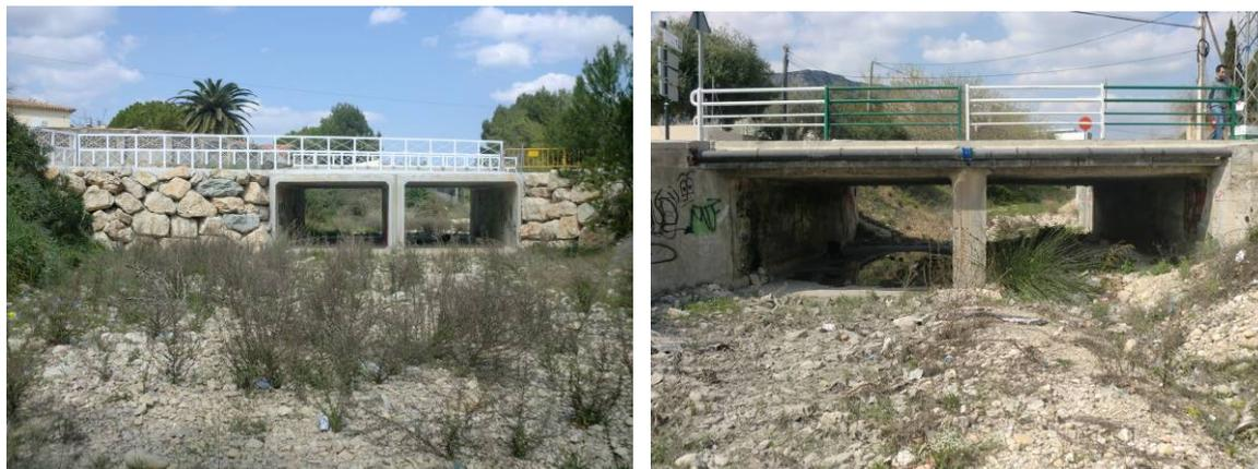
**Foto 10 y 11: Puente de la Partida Gargasindi donde se observa la reducción que suponen los cajones respecto a la anchura del cauce. A la derecha puente de la avenida Casanova parcialmente aterrado, ambos sobre el barranco del Pou Roig.**
