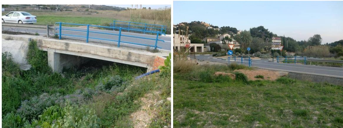
**Fotos 20 y 21: Paso transversal actual de la carretera CV-743 insuficiente. Derecha, al fondo rotonda inundable que conecta carreteras CV- 743 y CV-737**
