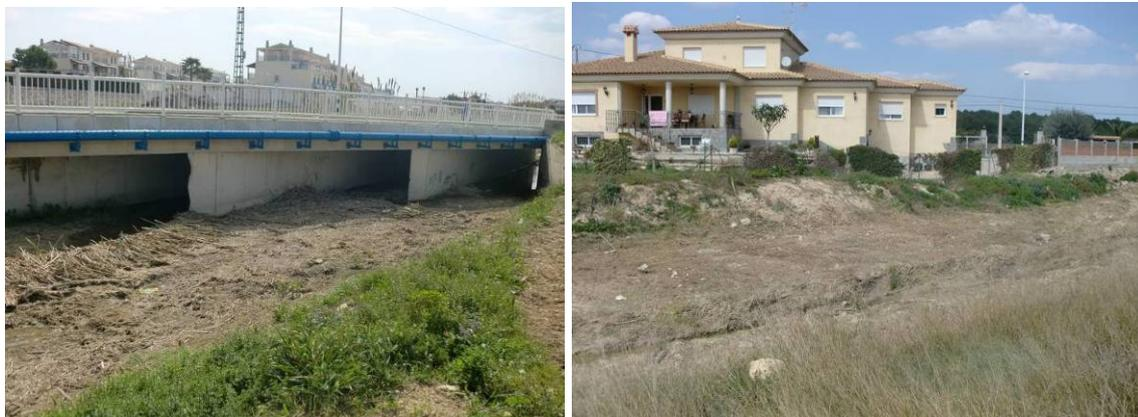
**Fotos 14 y 15: Puente de la avenida Casanova, se observa lo esviado de los marcos. A la derecha viviendas en margen derecho del barranco del Quisi tras atravesar puente de la avenida Casanova y que se encuentran muy expuestas a riesgos de inundación.**
