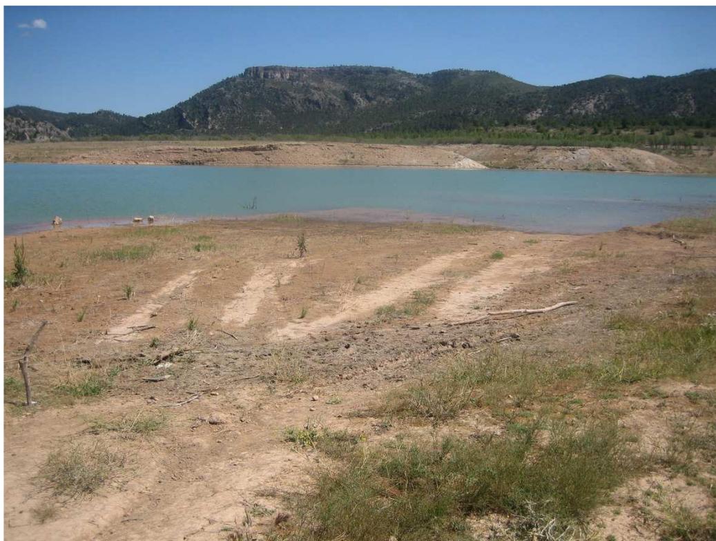
Fotografía n° 21: Tomas de agua. Imagen de uno de los puntos donde se propone la construcción de una solera para facilitar el tránsito de las cisternas contraincendios para reponer el agua en sus depósitos.
