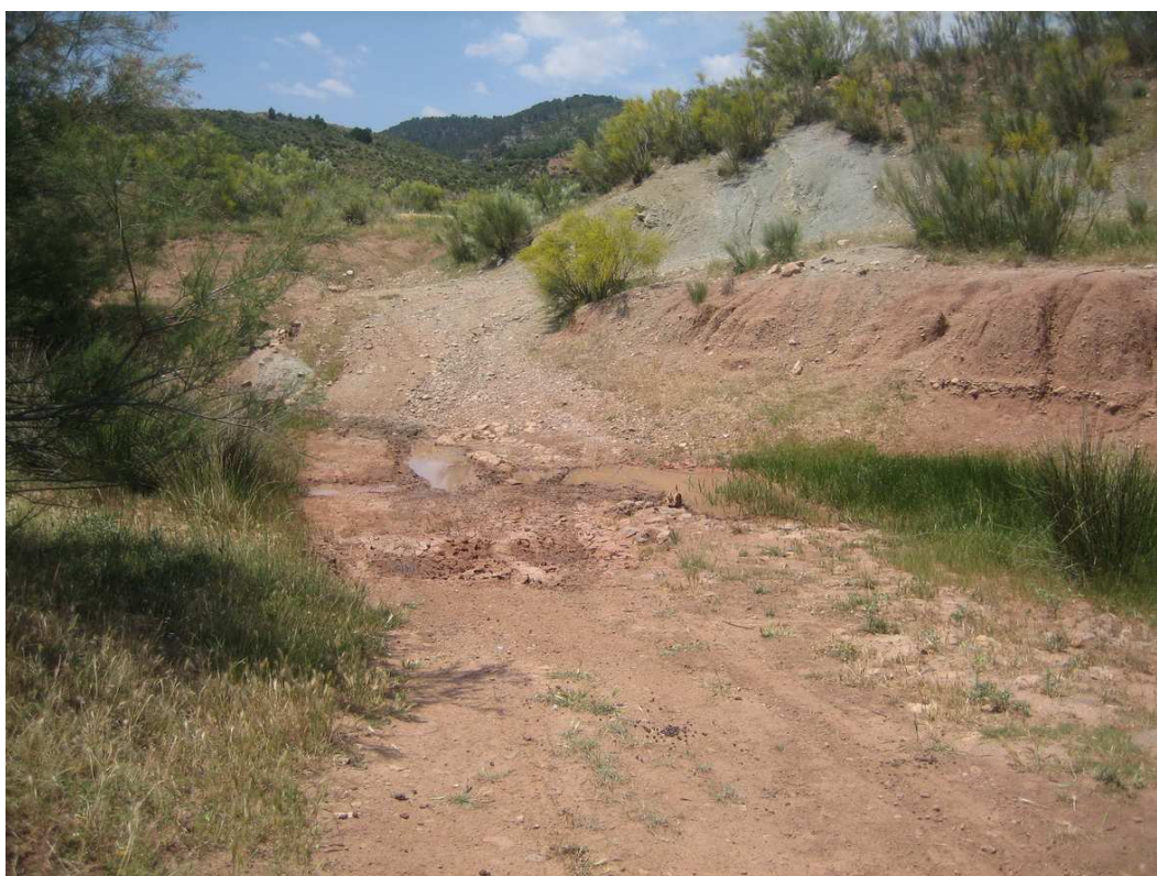
Fotografía nº 18: Construcción de badén con caño. En la parte meridional del camino 1 hay que construir un badén con caño para facilitar el paso por la pista hasta el final de la misma.
