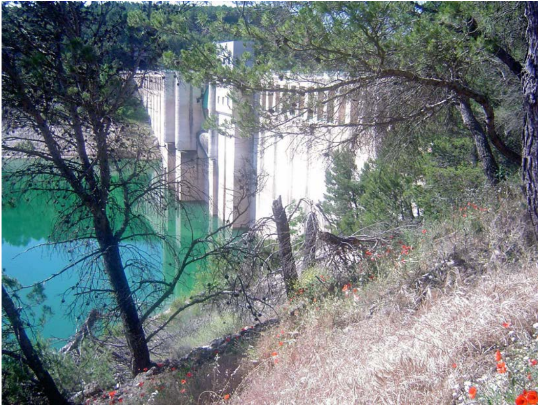
Fotografía nº 1: Vista general de presa del pantano. Se aprecia la necesidad de tratamiento selvícola sobre la masa forestal de pinar de pino carrasco.
