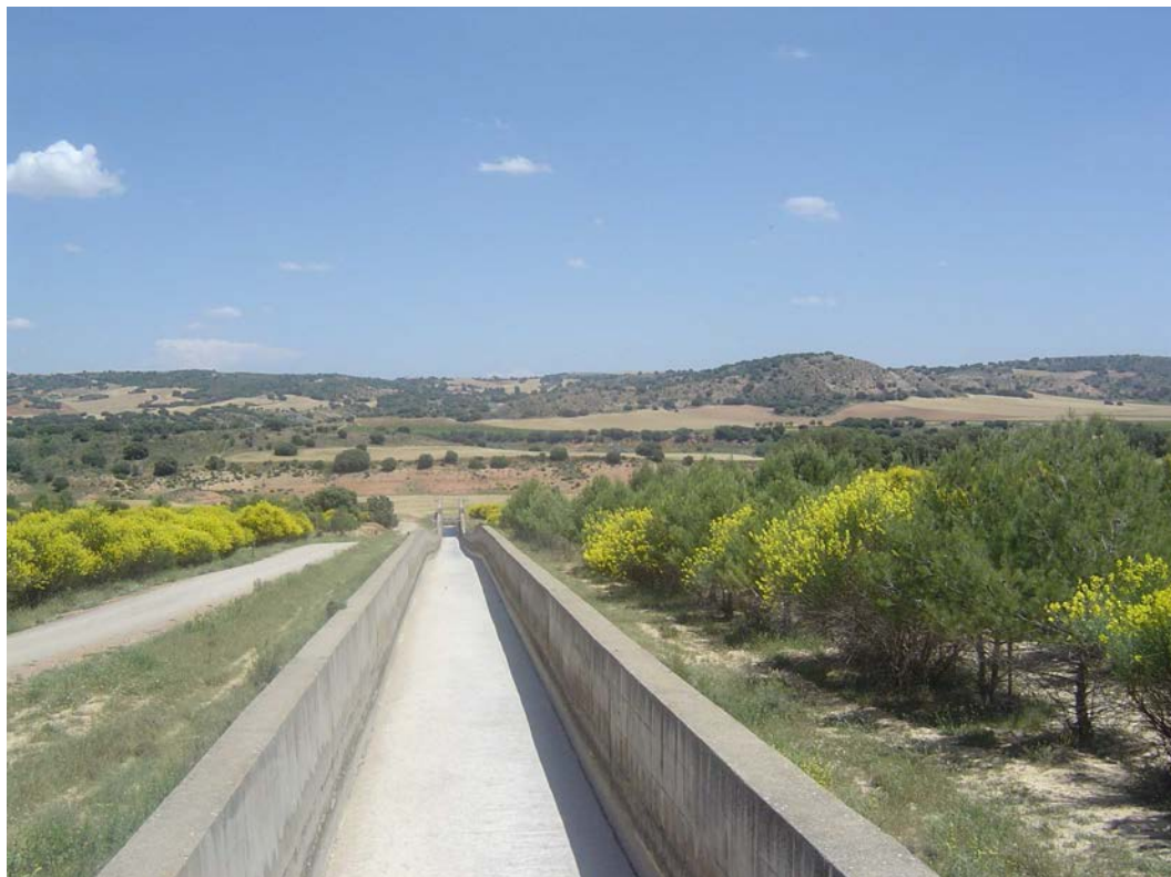
Fotografía nº 18: Vista de la cola del pantano donde se sitúa el canal de trasvase Tajo-Segura perteneciente a la Confederación Hidrográfica del Tajo.
