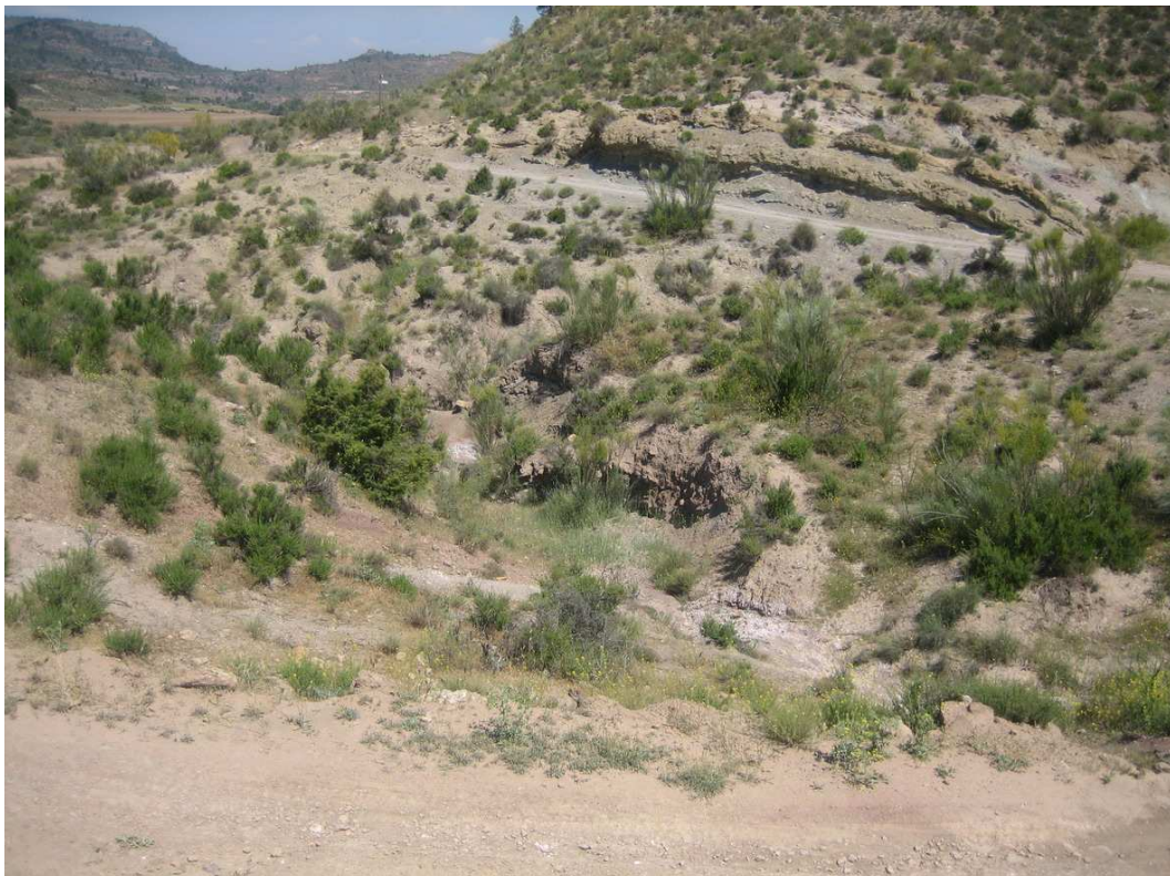
Fotografía nº 24: Construcción de gaviones. Vista de otro de los barrancos donde se proponen las albardas para frenar la erosión tanto en el cauce como en las márgenes.
