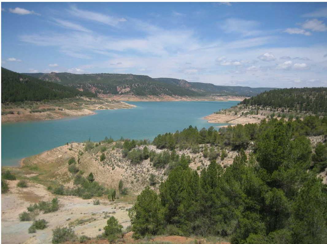
Fotografía nº 2: Otra vista general hacia aguas arriba donde se puede apreciar el avance de la vegetación hacia el interior del vaso del embalse y que esta rodeado de pinares de carrasco.
