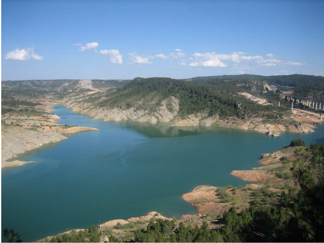
Fotografía nº 1: Parte baja del embalse. Se puede apreciar que la cota del agua no esta claramente definida por el avance de la vegetación ante el descenso de la cota de embalsamiento.
