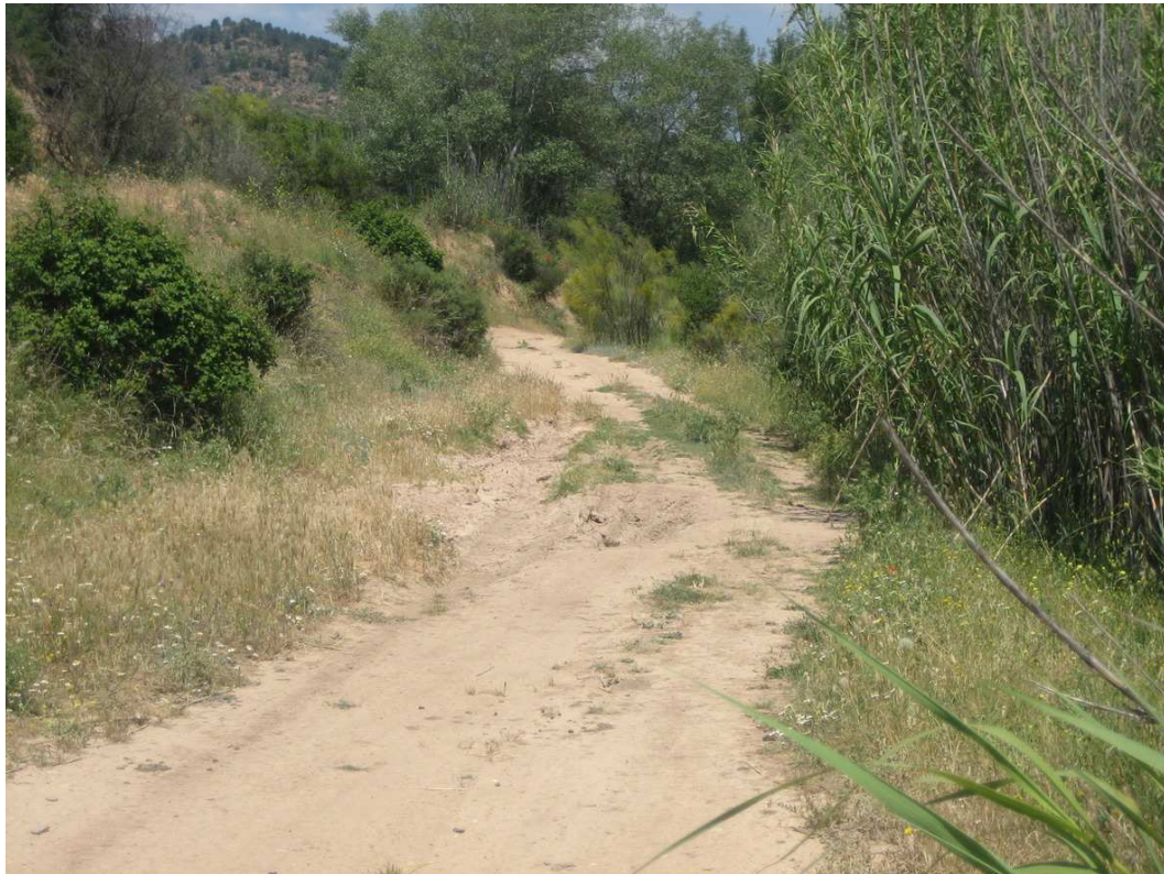
Fotografías nº 15 y 16: Caminos. Vistas del estado general de los caminos interiores a la propiedad de la C.H.J., donde se puede apreciar la necesidad de mejorar el firme de los mismos con aporte de zahorra, la apertura de cunetas y la construcción de badenes.
