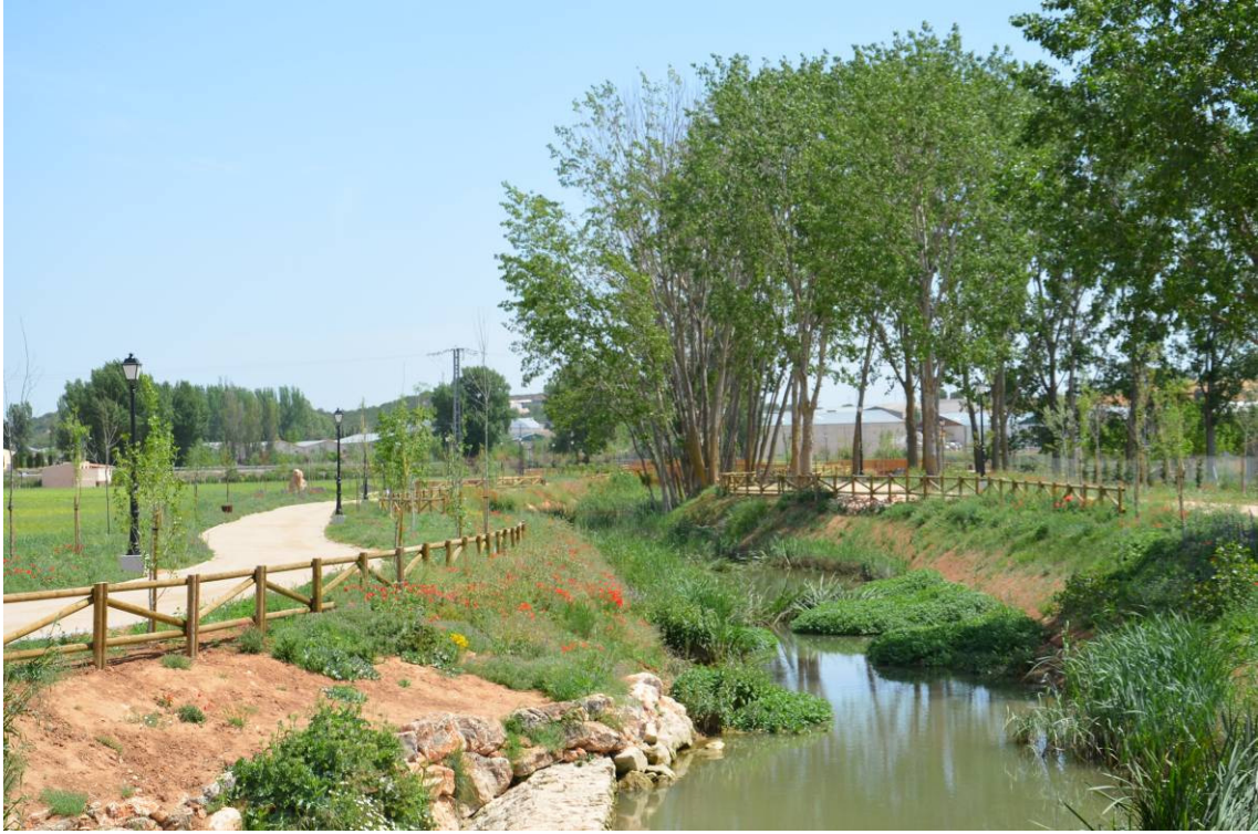
FOTO 1: Delimitación del cauce mediante vallado de madera.
