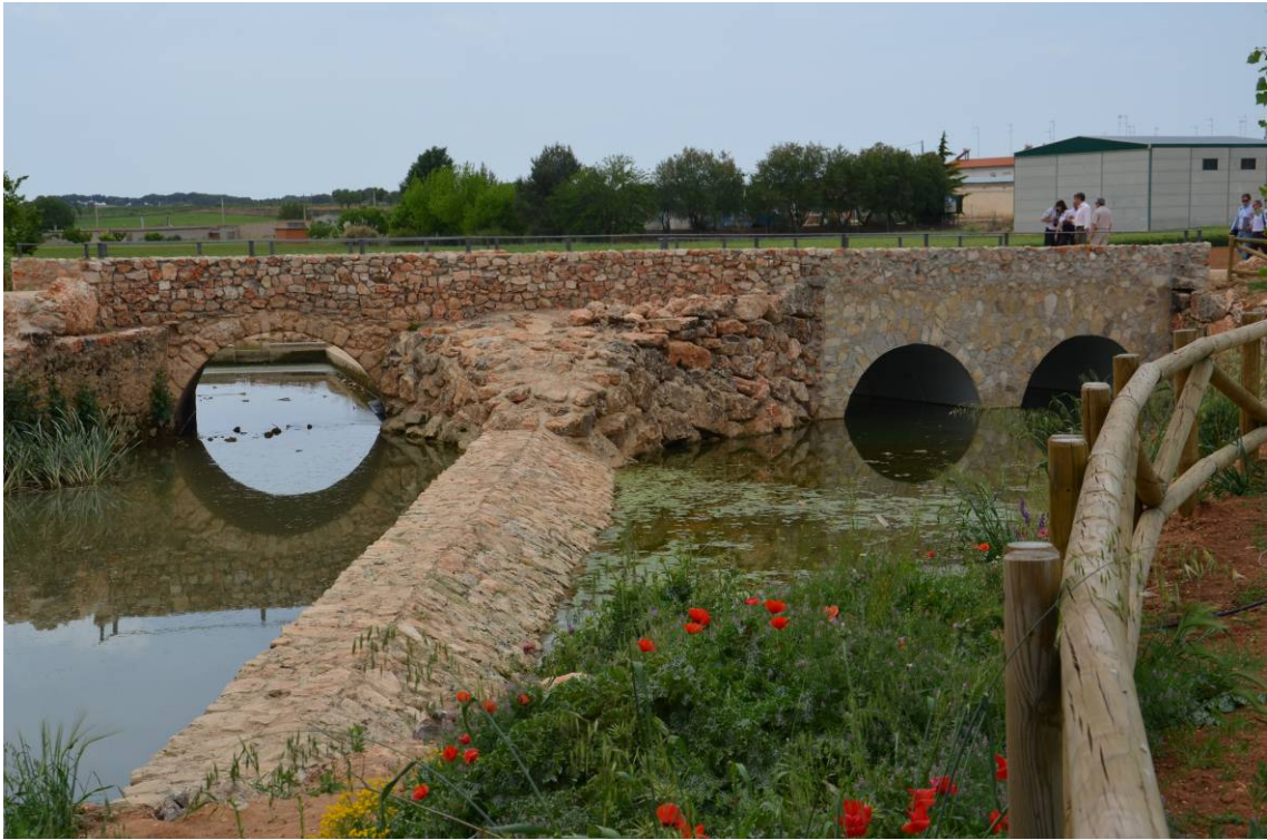
FOTO 5: Ampliación puente Camino Villagarcía
