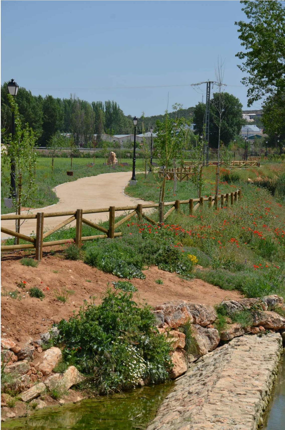
FOTO 3: Construcción aliviadero lateral.
