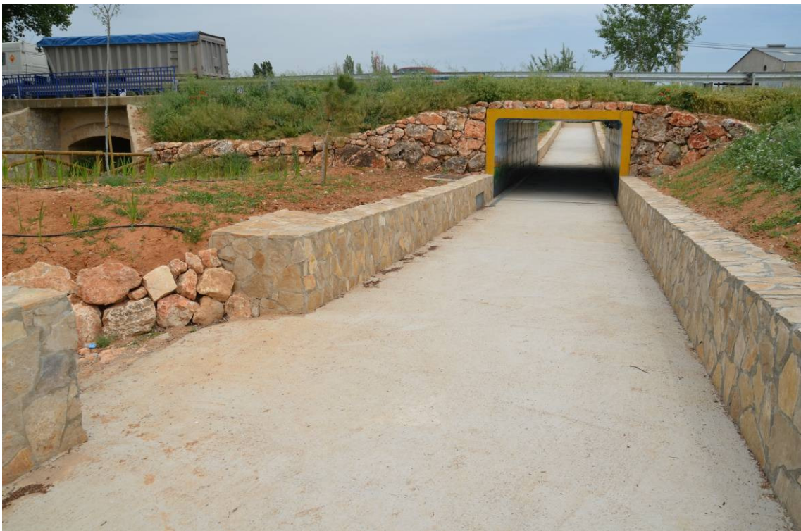
FOTO 6: Paso subterráneo comunicación entre fases y ampliación sección río.
