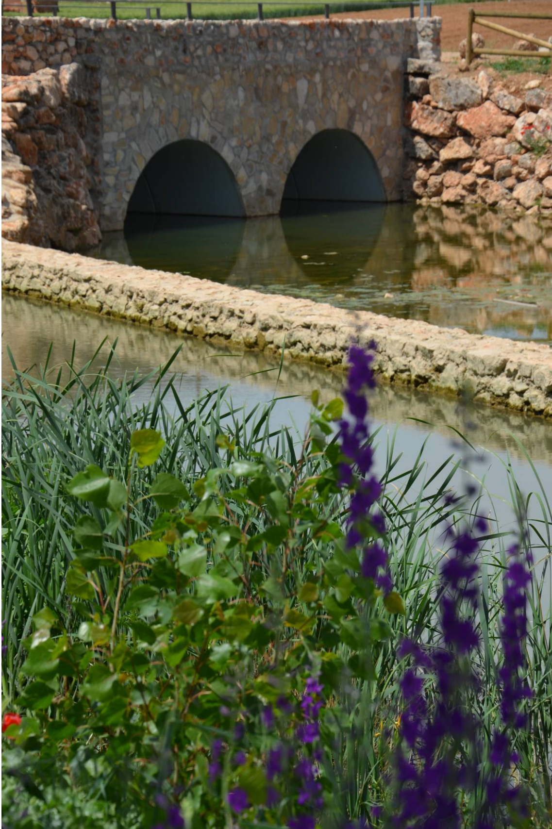
FOTO 4: Construcción aliviadero lateral y ampliación sección cauce.
