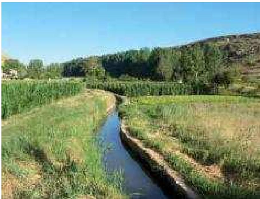
Figura 6-17: Ejemplo de red de distribución en gravedad
