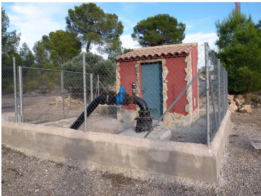
**Figura 6-15: Pozo de extracción**
