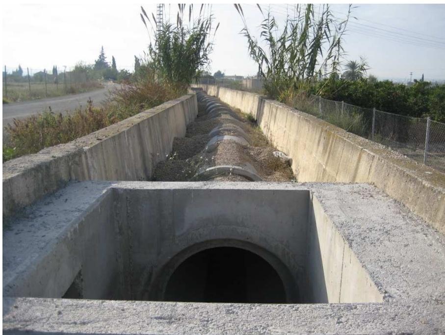
Figura 6-18: Ejemplo de red de distribución en presión
