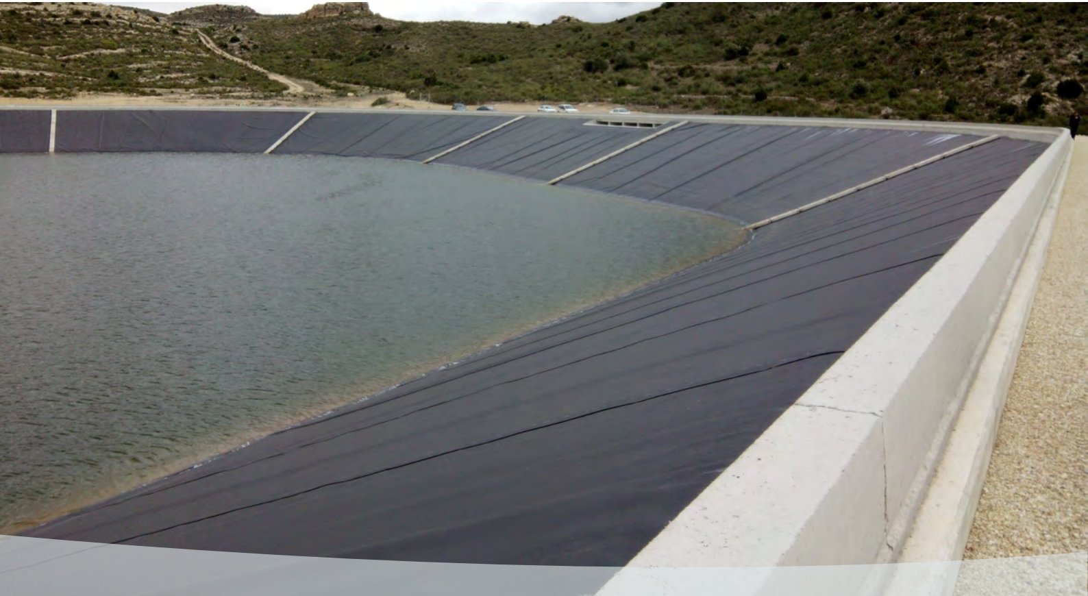
Construcció de basses.
