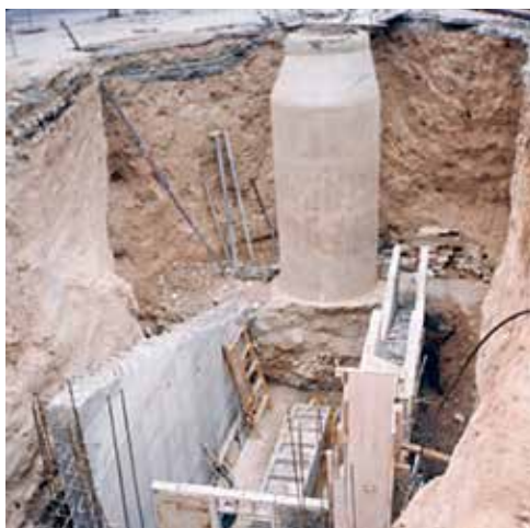
Imagen 8. Canalización alcantarillado, calle Fernando Madroñal-conexión con colector vía Parque
