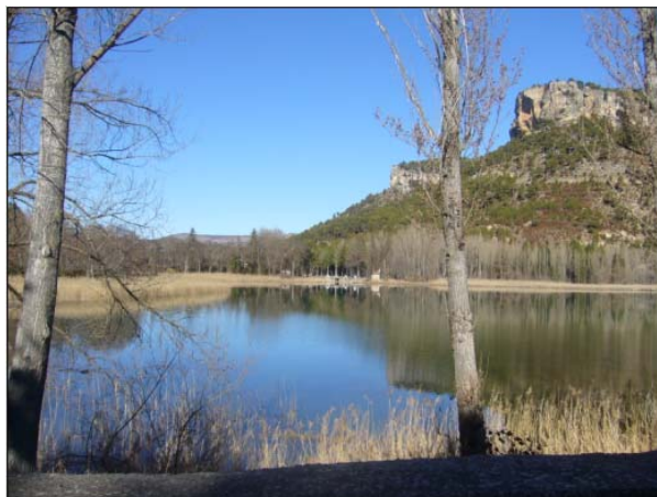
Figura 19 Laguna de Uña con la compuerta al fondo, que regula la salida del agua hacia el canal
