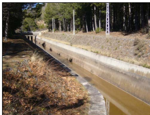
Figura 24. Canal que lleva agua de la laguna de Uña hasta la Central hidroeléctrica
