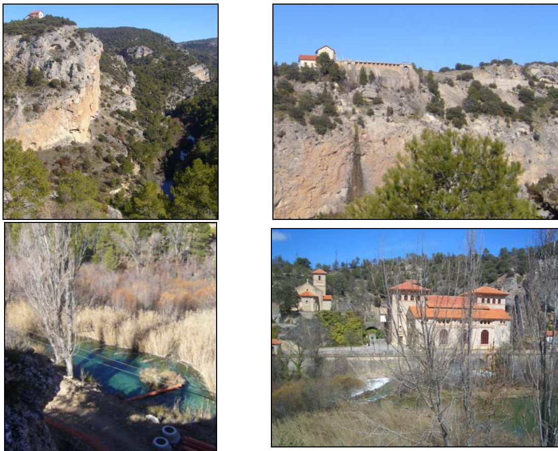
Figura 27. Vista del salto, de la central hidroeléctrica de Villalba y del retorno.
