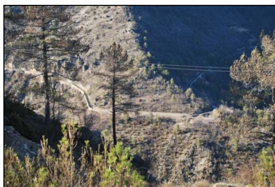
Figura 11 Canal de La Toba, a pocos metros aguas abajo del embalse.
