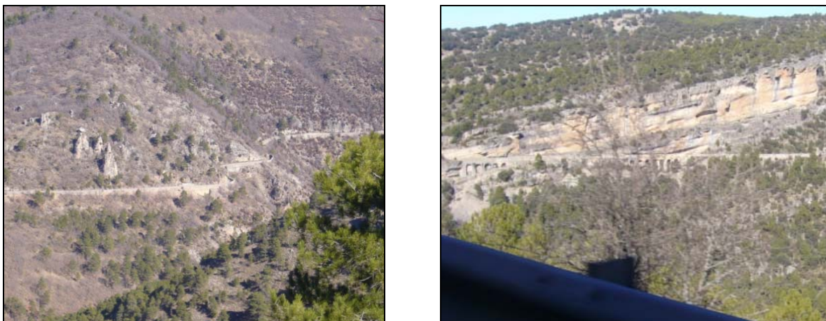
Figura 25. Vista del recorrido del canal laguna-central
