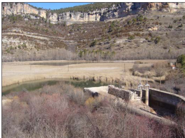
Figura 18 Compuerta que regula la entrada de agua del canal a la laguna de Uña
