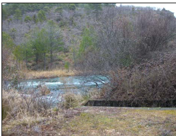
Figura 34. Vista lateral del canal de descarga del manantial de los Baños al río Júcar.
