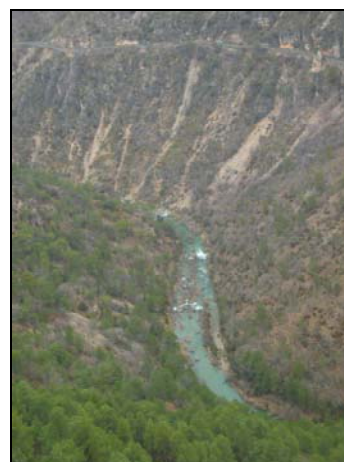
Figura 38. Vista del tramo Los Cortados desde la carretera.
