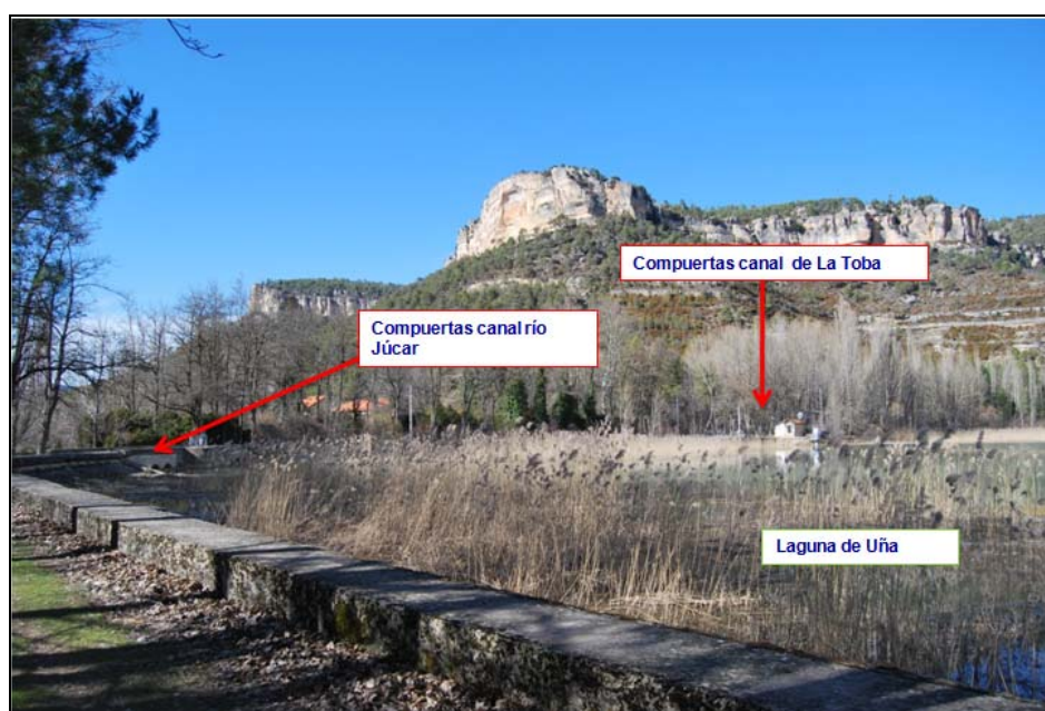
Figura 16 Sistemas de compuertas en la Laguna de Uña.
