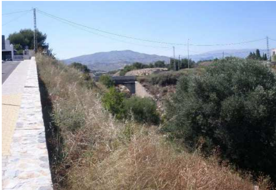
Estado actual del cauce
