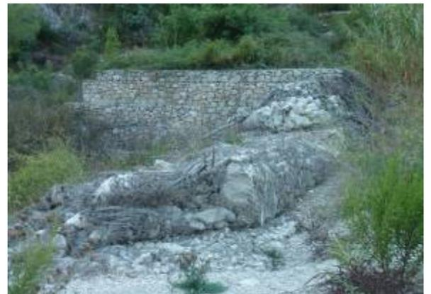
*Presas de retención de sedimentos situada aguas arriba del estrecho desmoronada durante las crecidas de 2007-2008.*
