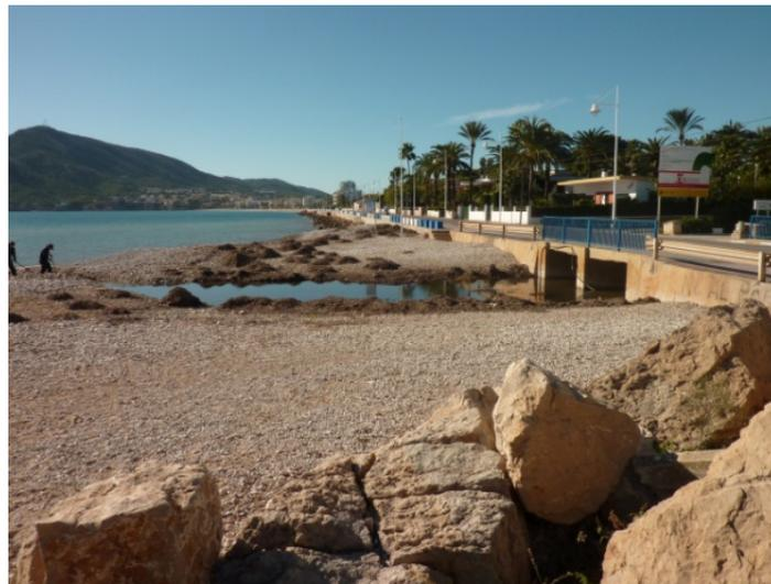
*Desembocadura del Barranc dels Arcs, tramo de costa erosivo defendido con escollera al sur del espigón del puerto.*
