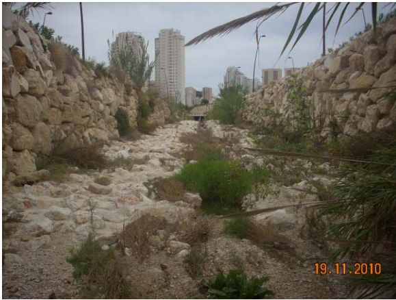
Canal abierto rectangular de base de 9 m y 4 m de altura de escollera. (Paralelo a la calle 9 de Octubre)
