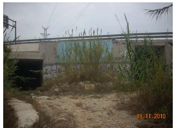
Paso inferior antigua carretera N-332. Izquierdo: Marco de 5.00x4.00m. Derecho: Marco de 4.00x5.00
