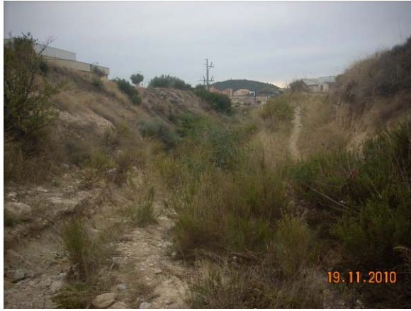
Barranco abierto paralelo a la calle Gandría. Sección trapecial con base entre 5 y 16 m y altura de 7 m.
