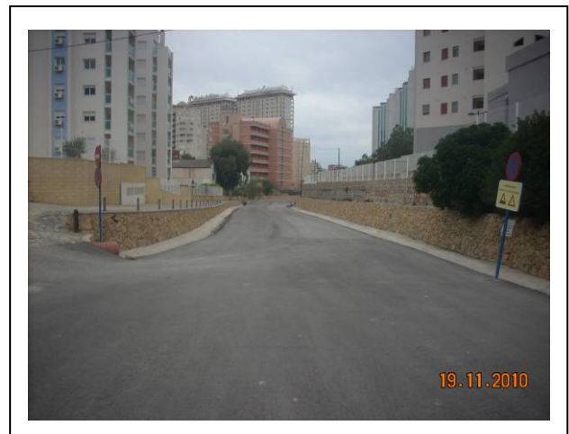
Canal abierto que discurre por la Avenida de Finestrat hasta la Avenida de Marina Baixa. Anchos que varían alrededor de los 9 m y altura de 1.50 m
