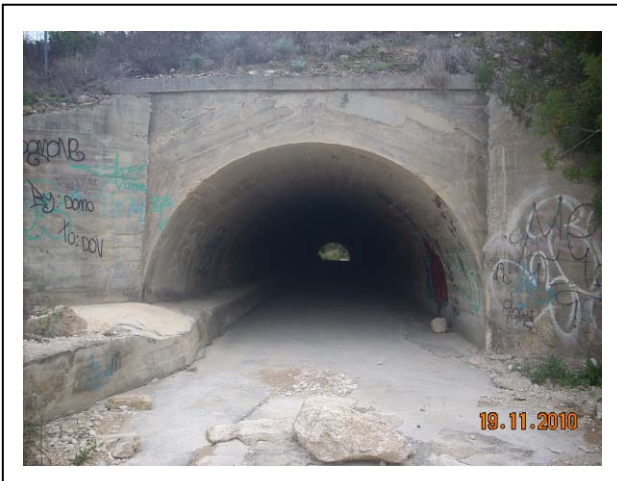
Paso bajo la AP-7 Sección circular de 5 m de base y 3 m de altura
