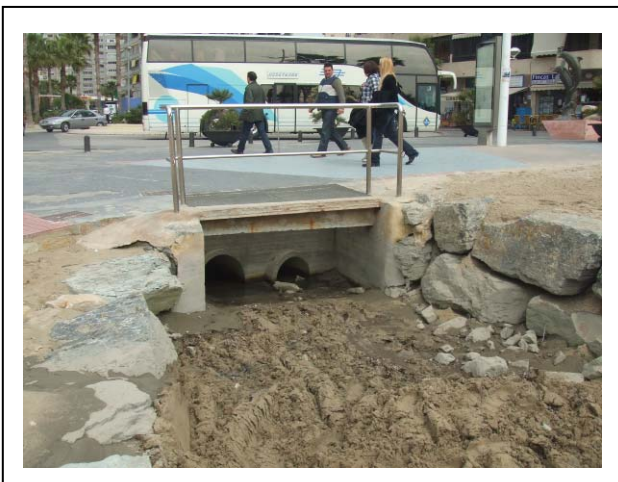
Vista desde aguas abajo de la obra de paso (FIN-101) de la citada rotonda.
