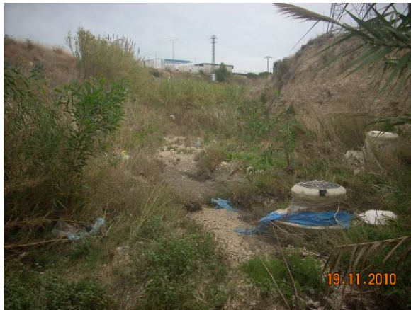
Barranco abierto de sección trapecial de base entre 6 y 10 metros y altura de 7 metros.
