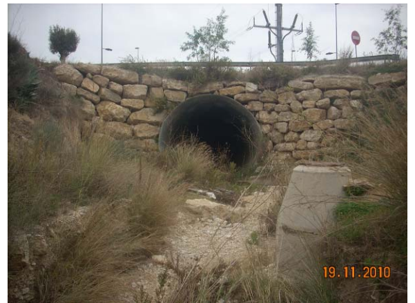
Cruce inferior rotonda Avda. Pias Valenciá y C. Asturias. Tubo de de chapa de 5 m de diámetro.
