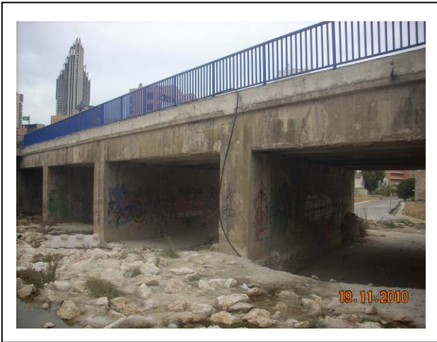
Puente de la Avenida de Finestrat. Cruce formado por 4 ojos de 7 metros de ancho por 3.30 metros de altura. (FIN -102)
