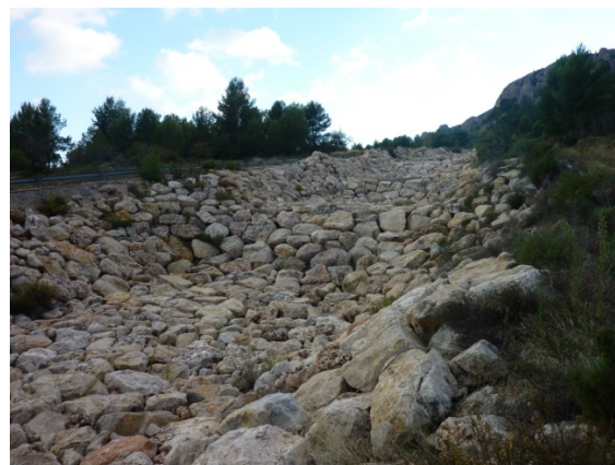
Inicio del desvío del Barranc de la Canal. Muro de hormigón de altura irregular en el margen. Cauce revestido de grandes bloques
