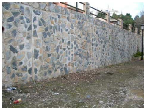
Muro de hormigón revestido de mampostería en el Barranc del Gulapdar
