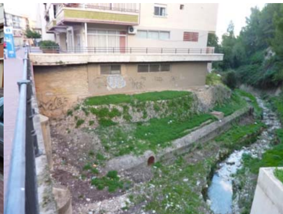
Barranco del Gulapdar aguas abajo del puente de la carretera (final del tramo).
