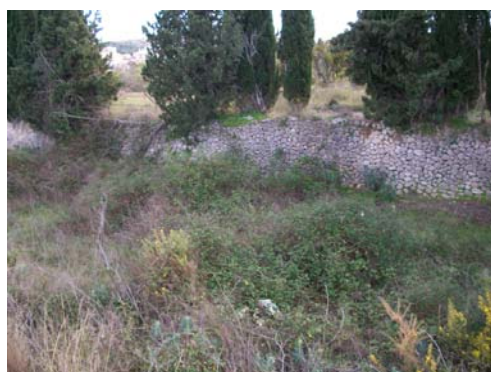
Muro de mampostería en seco en el cauce del Gulapdar
