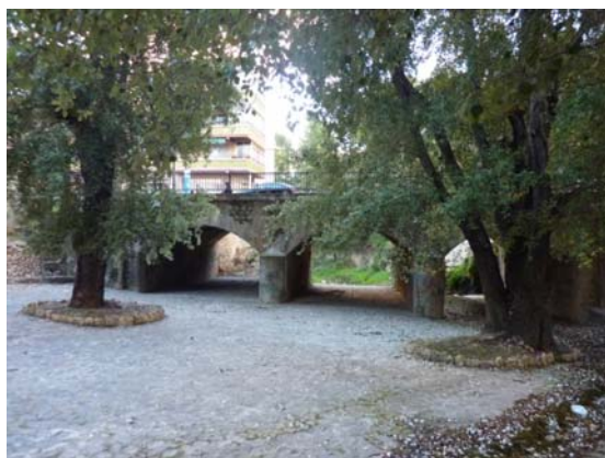
Puente sobre el Barranc del Gulapdar
