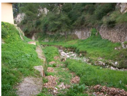
Vista cauce aguas abajo del puente de Polop
