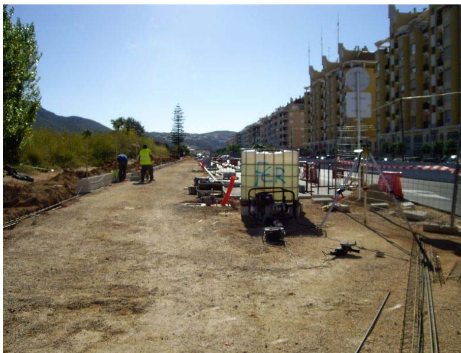
Fotos 12 y 13: Arriba: Vista del canal de desagüe del saladar antes de las obras de urbanización de la calle paralela a la vía del tren; abajo: Vista de las obras de urbanización de la calle paralela a la vía del tren.
