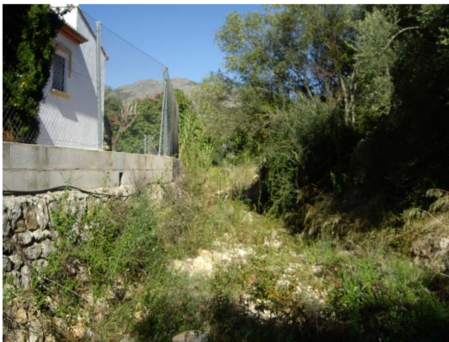
Foto 17: Foto desde la desembocadura del culvert hacia aguas abajo
