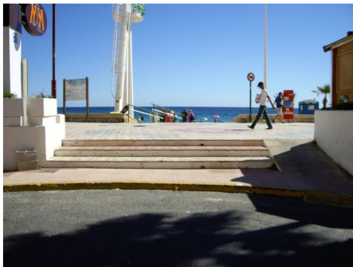
Foto 28: Escalones de acceso al paseo marítimo que impiden desaguar desde las salinas.
