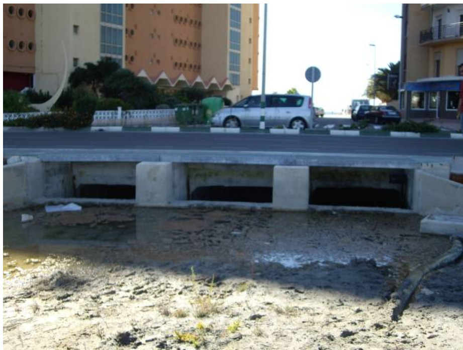
Foto 27: Salida al mar del drenaje de las salinas mediante tres marcos.
