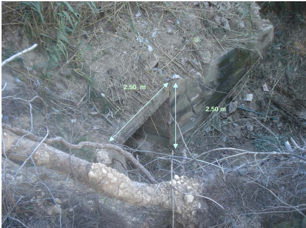
Foto 21: Vista del desagüe de fondo de la presa de agujero.
