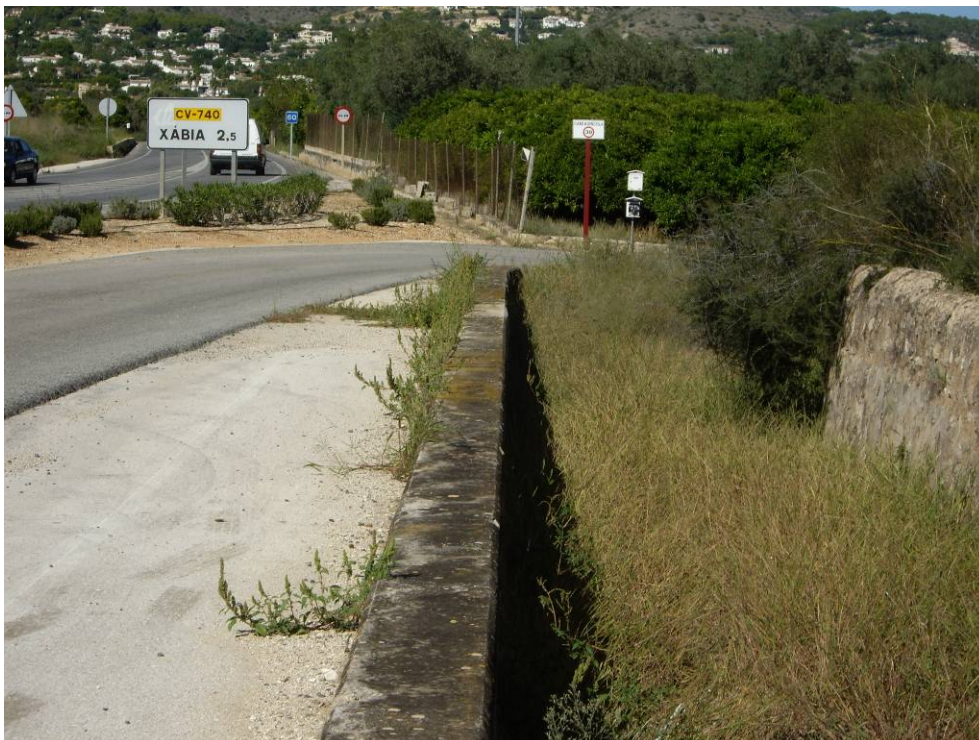
Foto 14: Tramo encauzado del barranco de la Lluca
