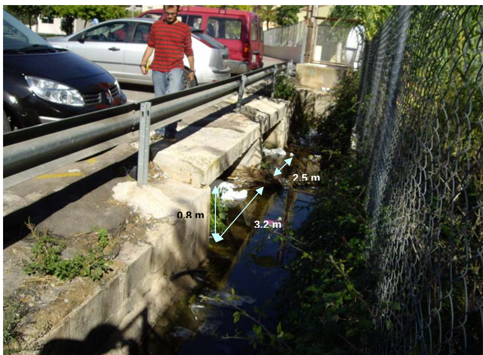
Foto 11: Entrada a la estructura subterránea del Barranc de Coll Pou
