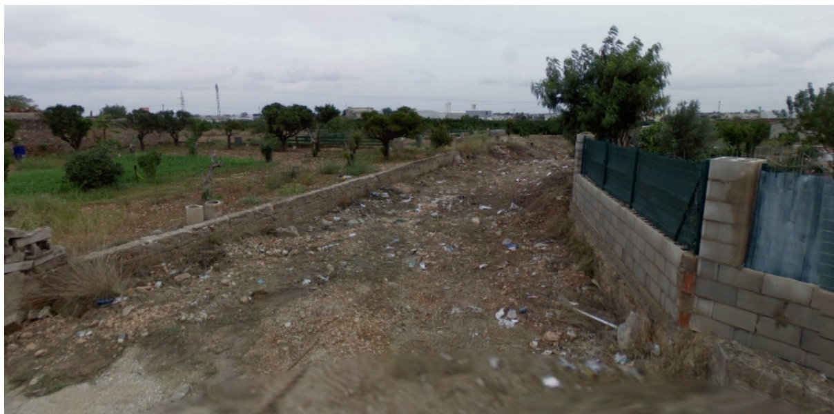
Foto 6: Muretes de contención en zona entrada del modelo en barrano de Portelles
