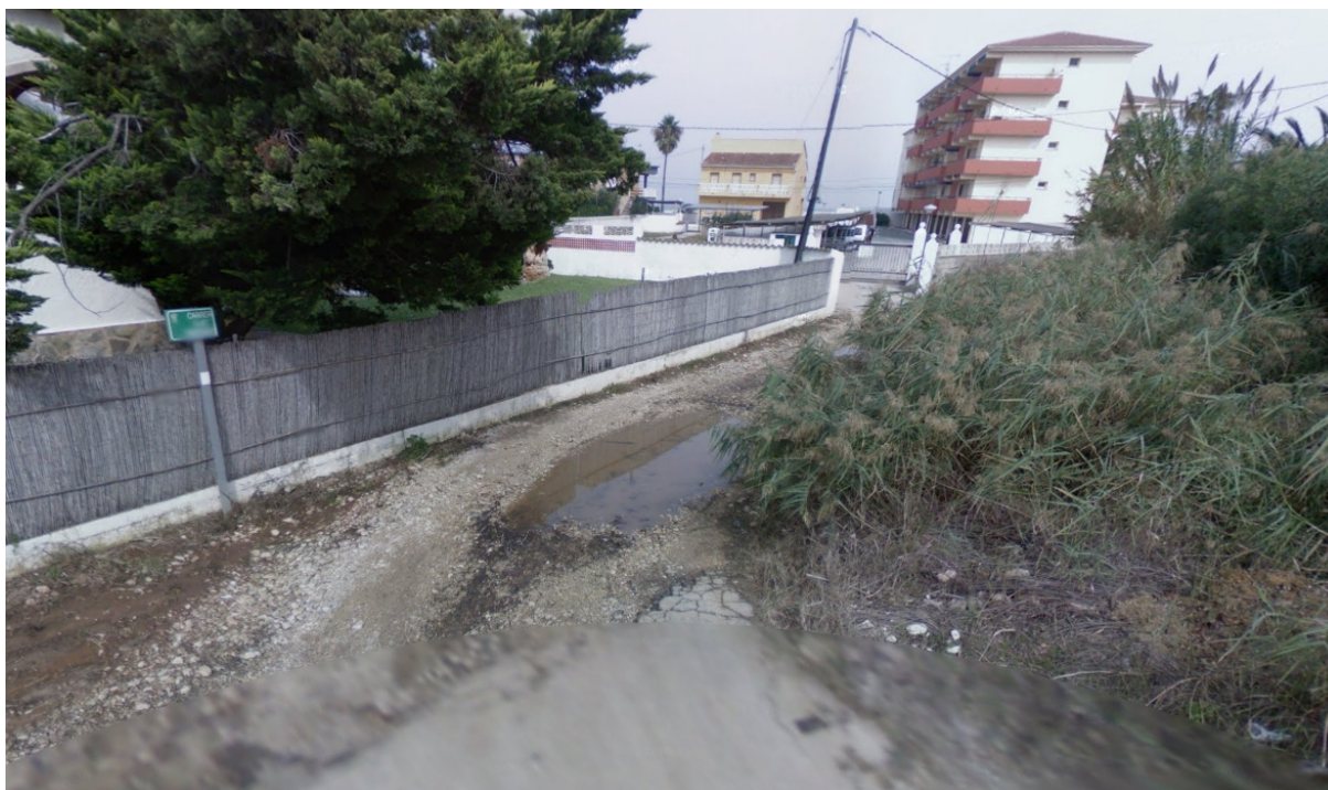
Foto 5: Carrer de Sanabria junto bco. la Alberca por donde discurren las aguas desbordadas.
