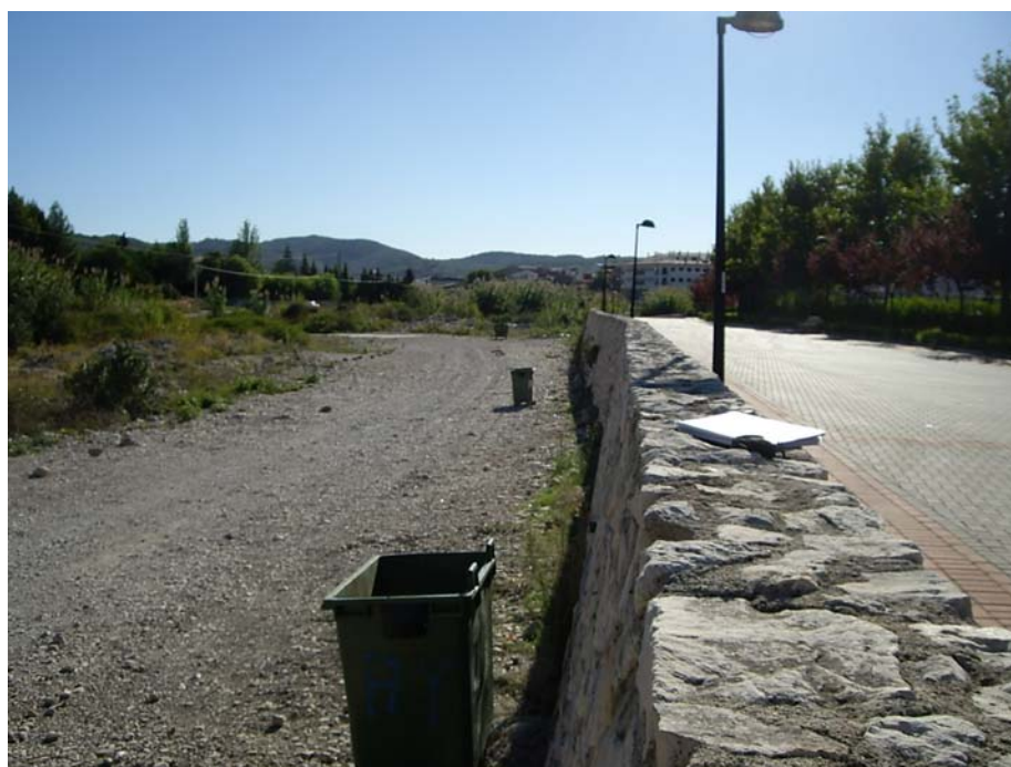
Foto 18: Muro del paseo frente a Xaló
