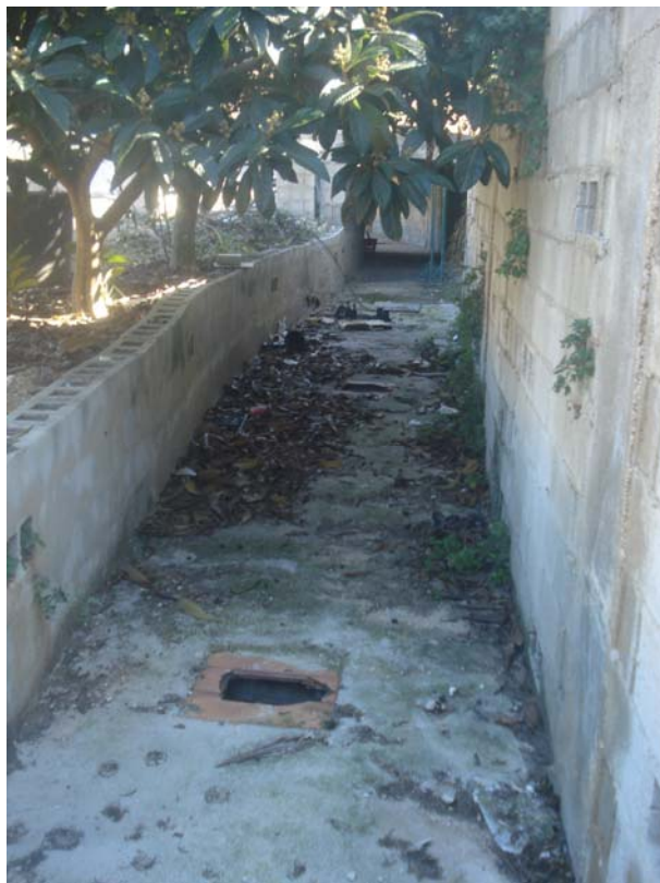
Foto 22: Entrada del paso inferior del barranco que confluye al barranco de la Fustera por su margen izquierda.
