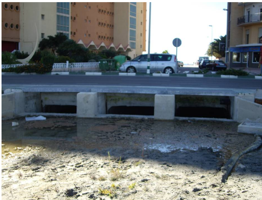
Foto 25: Foto de la entrada del culvert de desagüe de la salina al mar
