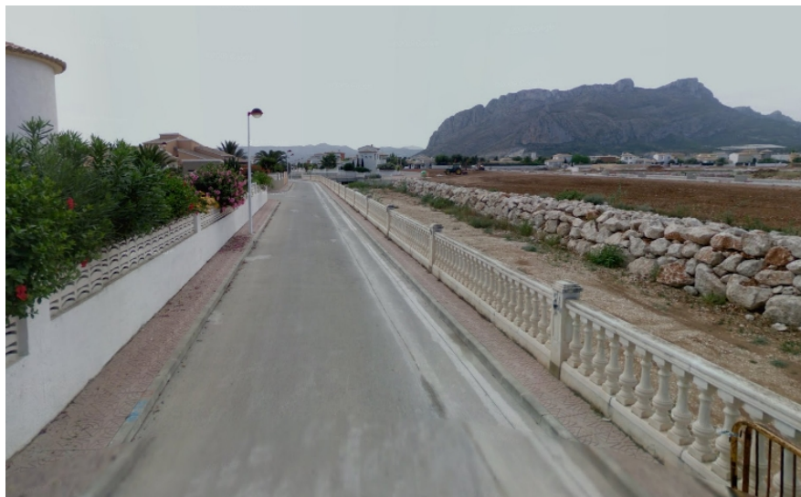
Foto 4: Sección encauzada barranco Portelles junto a urbanizaciones.
