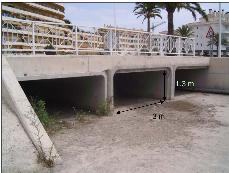
Foto 20: Entrada del culvert
