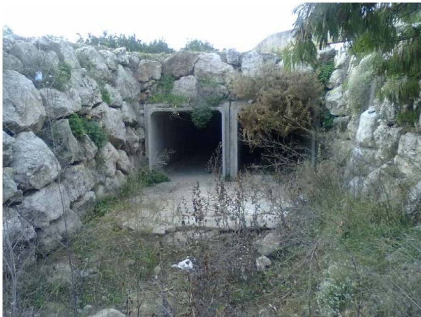
Foto 29: Imagen de la entrada al colector
