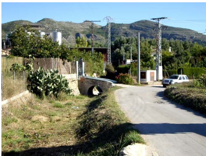
Foto 19: Sección barranco de Passules (entrada Jalón 05)
