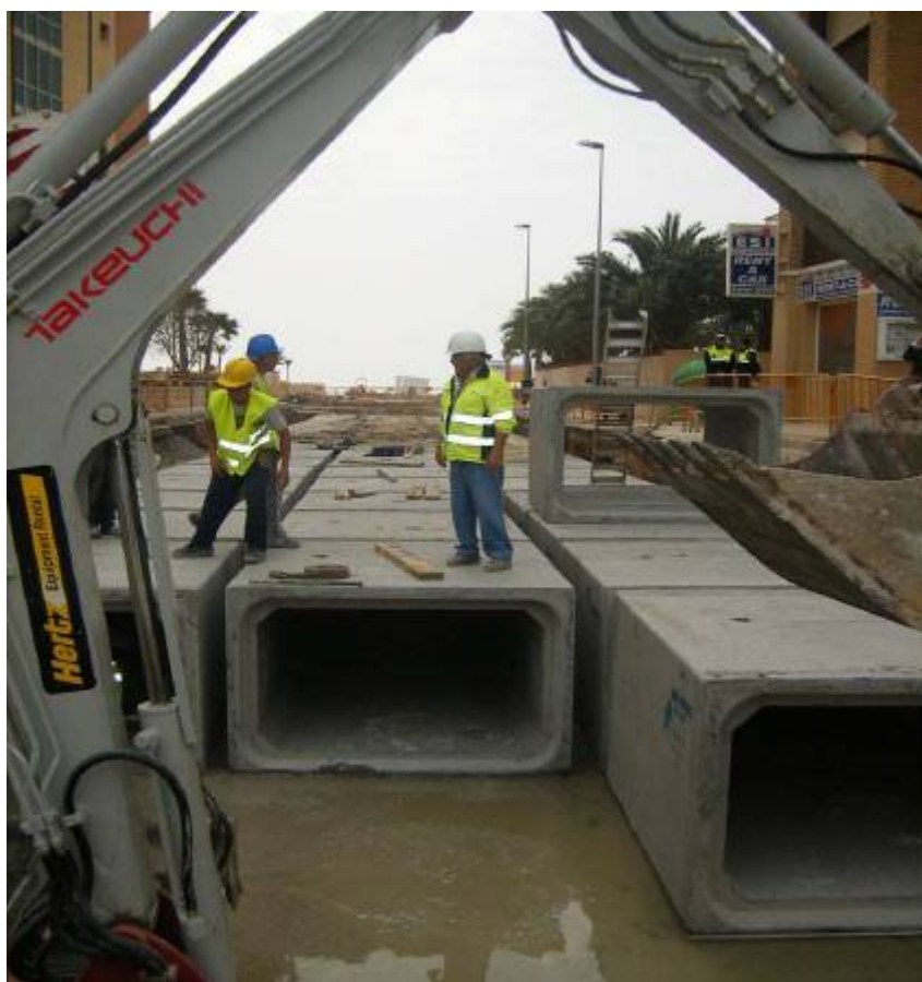
Foto 24: Foto de la construcción del paso inferior que conecta la salina con el mar
