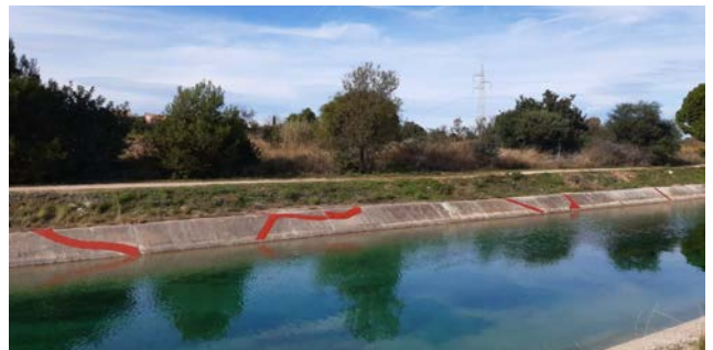
Reparación de juntas en el Canal del Júcar
