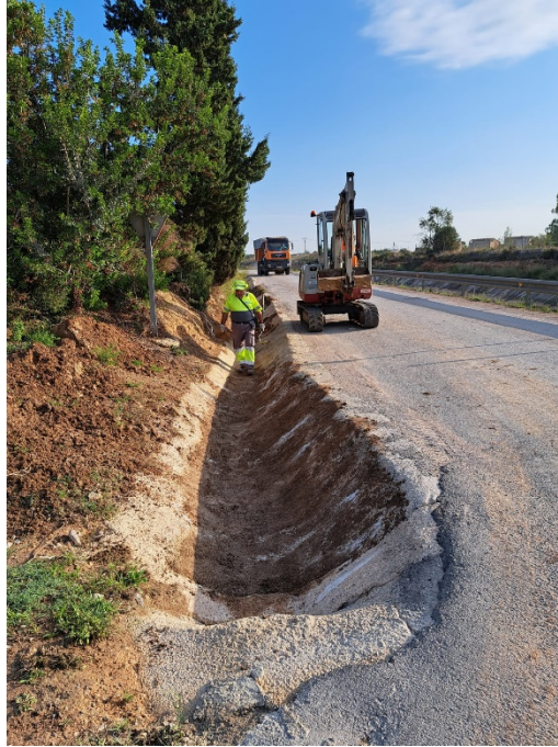
Mantenimiento de vía de servicio
