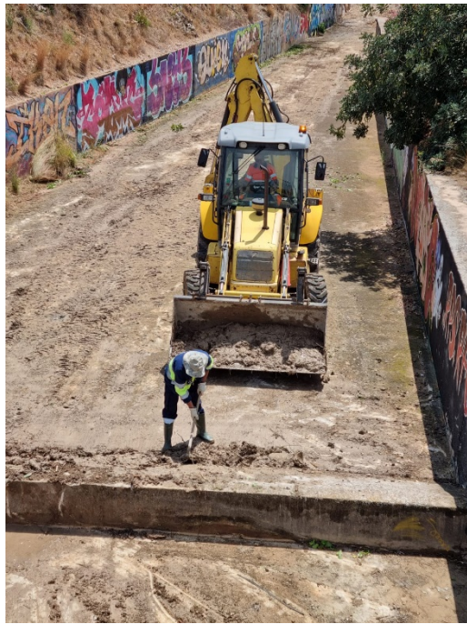
Limpieza de canales e infraestructuras tras lluvias torrenciales
