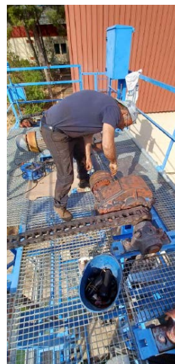
Desmontaje y reparación de las cuatro reductoras de las cántaras de la presa de Tous.
