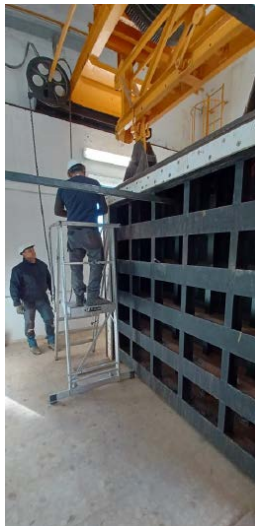
Acondicionamiento de las dos ataguías de los conductos del desagüe de fondo de la presa de Contreras.
