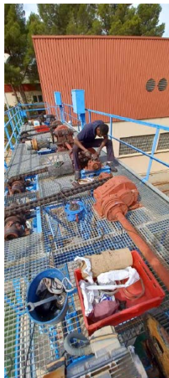
Desmontaje y reparación de las cuatro reductoras de las cántaras de la presa de Tous.
