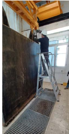
Acondicionamiento de las dos ataguías de los conductos del desagüe de fondo de la presa de Contreras.
