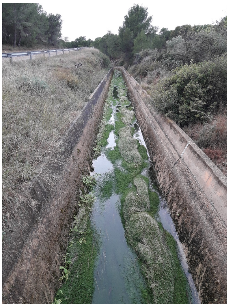
Tramos de limpieza interior del canal
