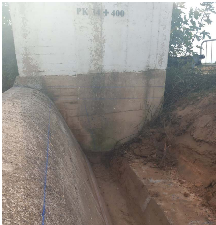
Ejecución de un by-pass en la antigua toma del sector XIV del canal
