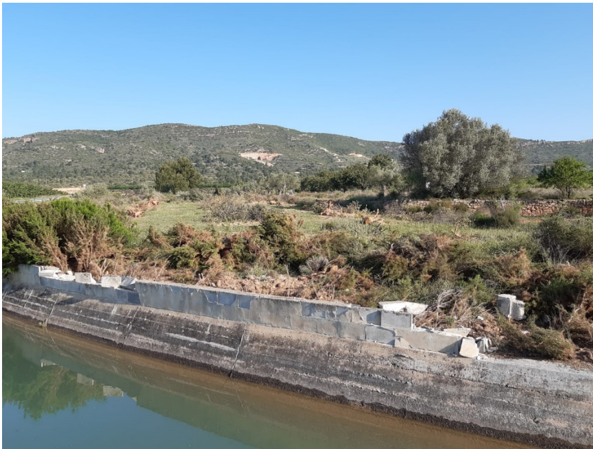
Tramos de recubrimiento y recrecido de cajeros del canal
