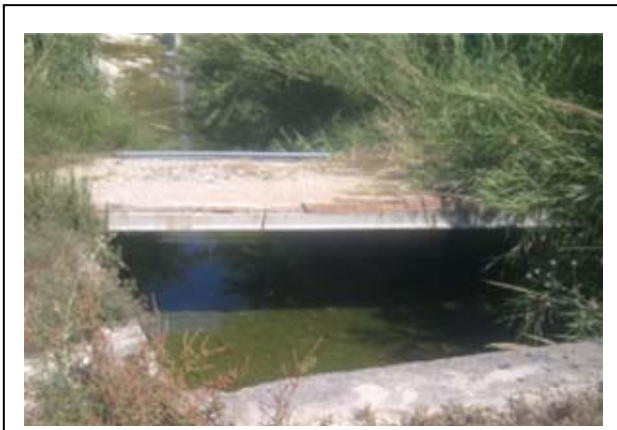
Vista del pontón de un acceso privado, obra de paso CALL103 en el río Bolulla
