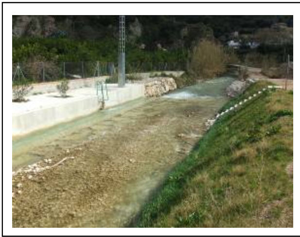
Vista hacia aguas abajo de las instalaciones de la estación de aforos de la Confederación Hidrográfica del Júcar, ubicadas en el río Bolulla aguas arriba de la desembocadura al río Algar.
