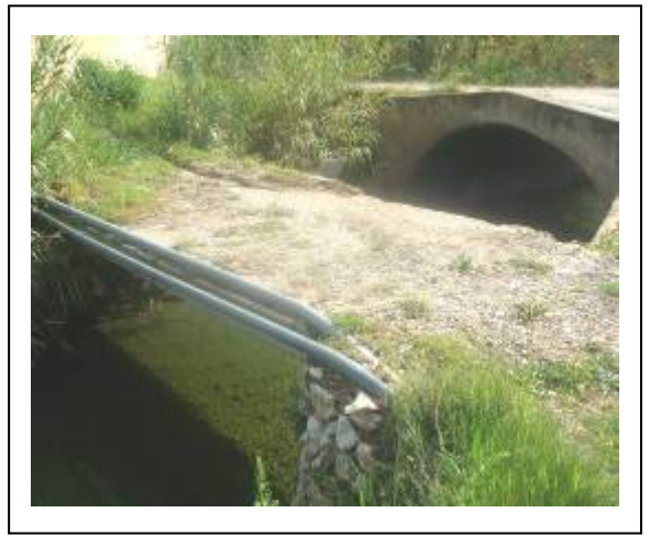
Vista de dos obras de paso contiguas inmediatamente aguas arriba de la unión con el río Algar (cruces CALL103 y CALL102)..
