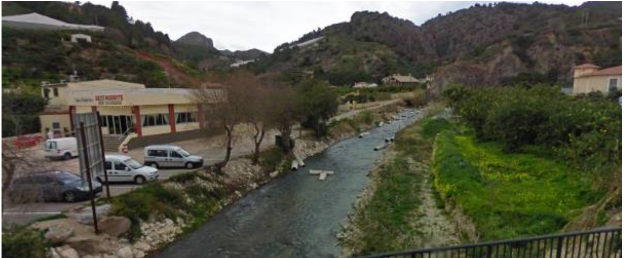
Foto desde el puente de la carretera CV7531 hacia aguas arriba
