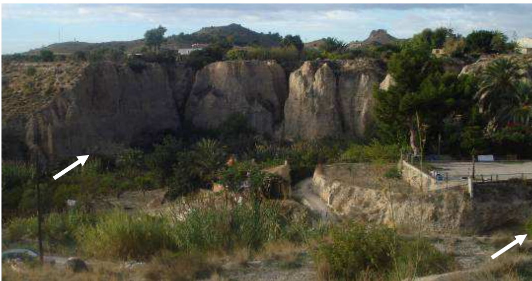
Confluencia del barranco de la Robella con el río. Se observan profundos acarcavamientos y un derrumbe reciente en la margen derecha, así como procesos de zapa basal en el barranco (flechas).
