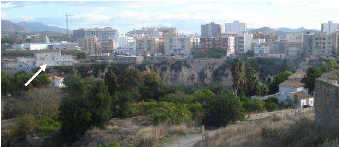
Cauce del río en su confluencia con el barranc de l'Arquet. Al fondo viviendas expuestas de la c/Ribazos.
