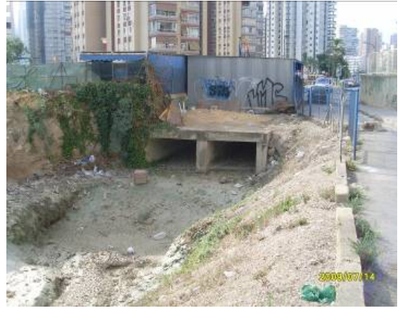
Vista de la entrada al colector urbano
