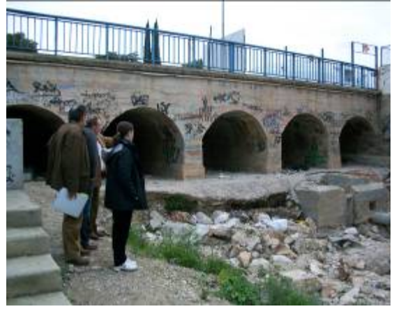
Vista de aguas abajo del puente de la antigua carretera N-332
