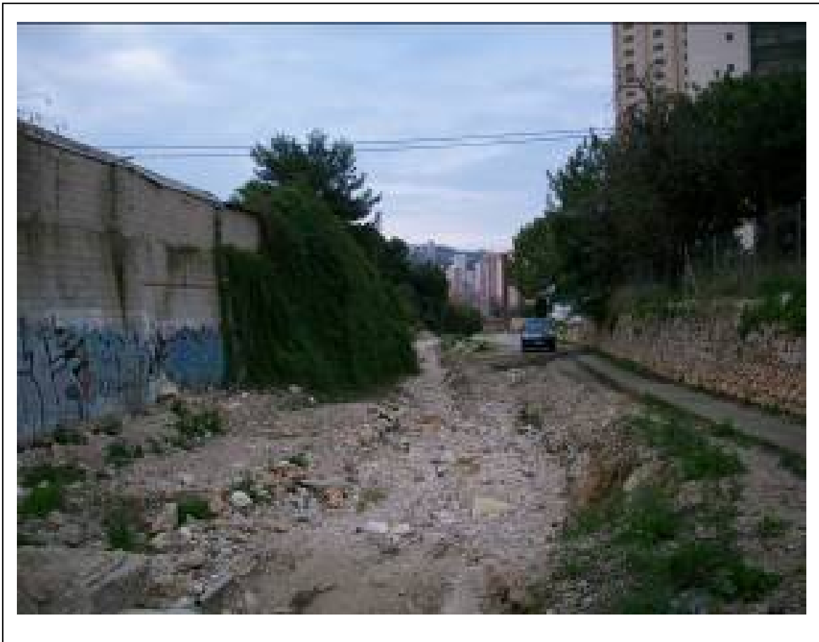
Arriba. Vista del barranco aguas abajo del puente de la antigua carretera N-332.
