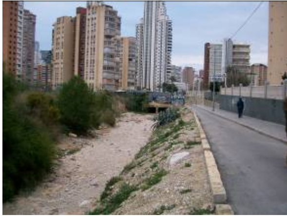
Vista del barranco en el tramo denominado Avenida del Derramador
