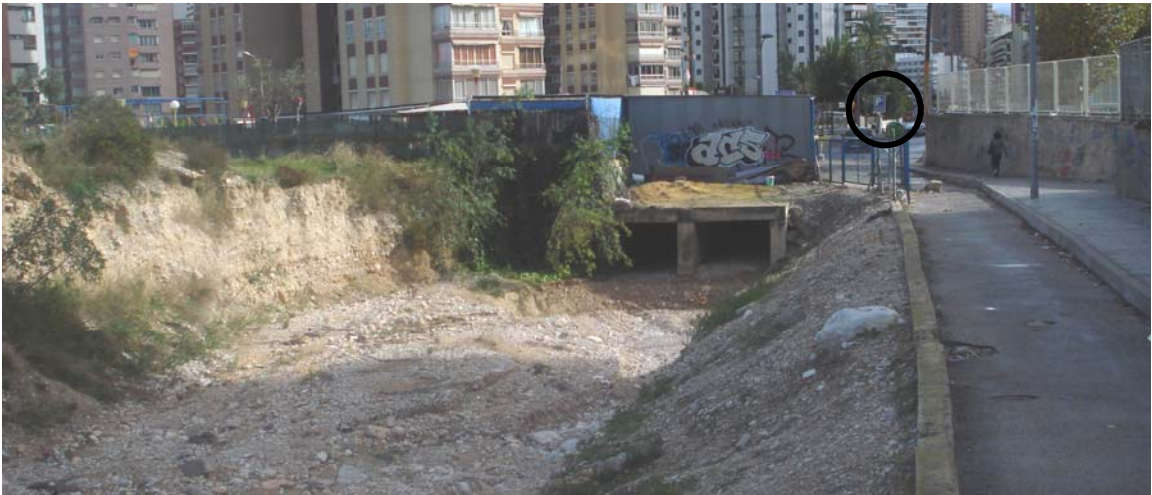
Avenida del Derramador. Arriba incisión del cauce y material grueso tras el puente de la antigua carretera nacional. En el centro, instalaciones del hotel Flamingo Benidorm invadiendo el lecho del barranco y expuestas a las aguas de crecida. Por último, encauzamiento subterráneo y localización del parking.
