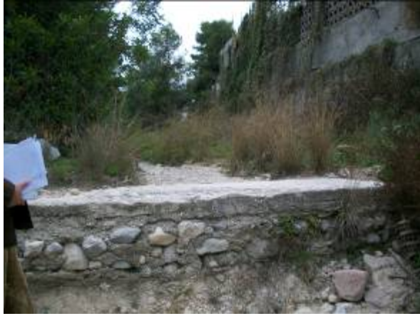
Vista de dique de mampostería para estabilización
