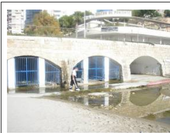
Vista de la desembocadura del colector en la playa mediante dos secciones abovedadas
