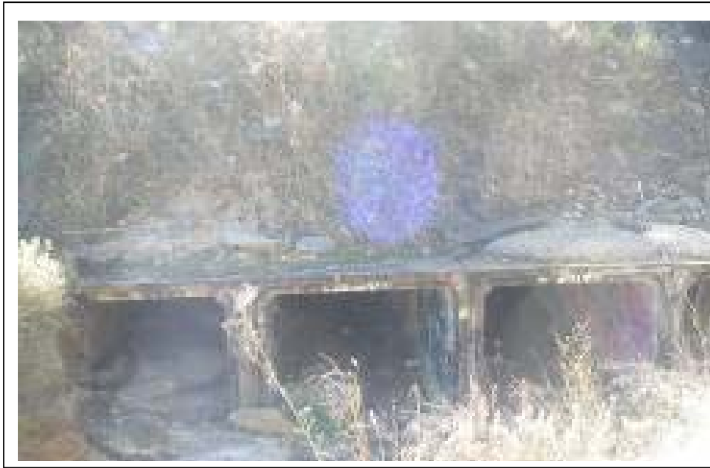
Vista de la embocadura del colector de la Avenida de Cuba.
