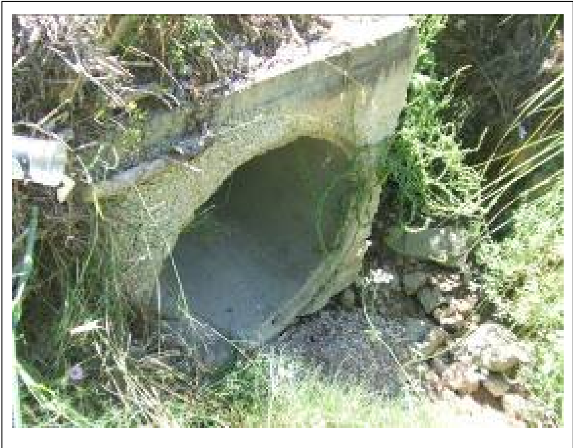
Vista del cruce BEN-112 (badén) desde aguas abajo
