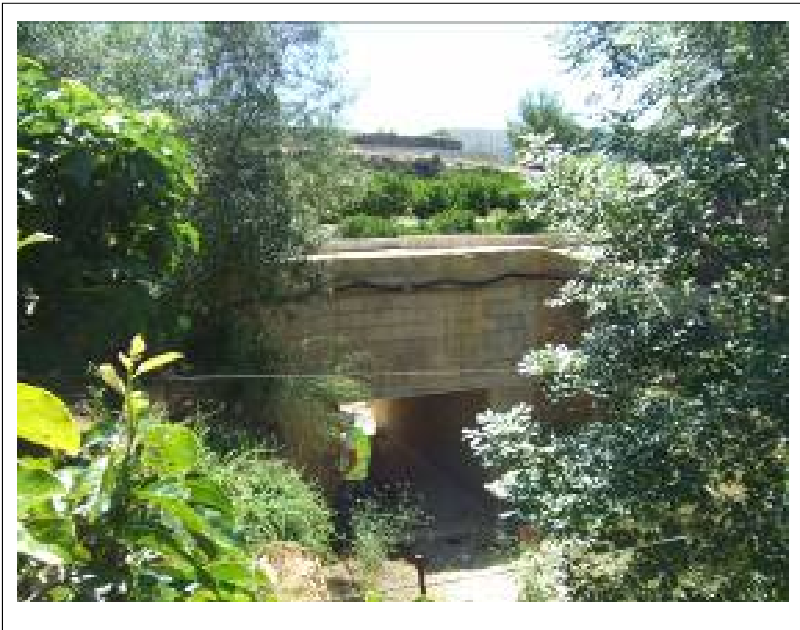
Vista del cruce BEN-111 (pontón) desde aguas abajo
