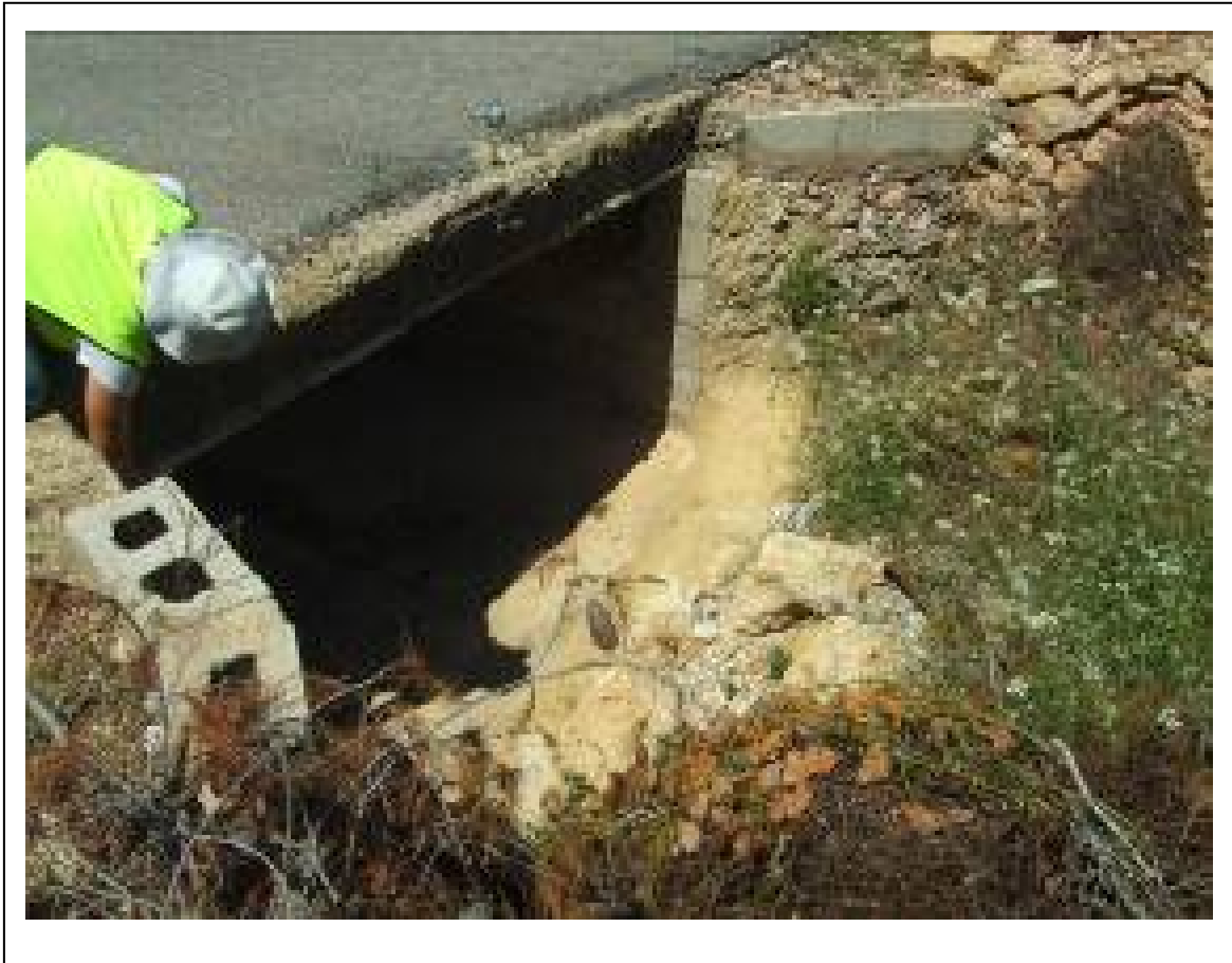
Vista del cruce BEN-110 (pontón) desde aguas abajo
