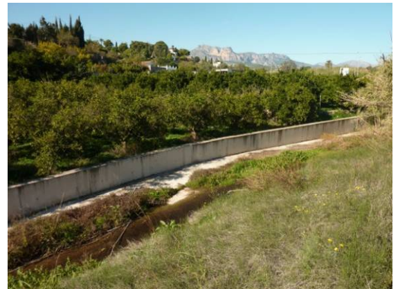
Tramo encauzado junto al Camí Vell d'Alacant, que discurre paralelo sobre un terraplén sobreelevado por la mara en la izquierda del barranco.
