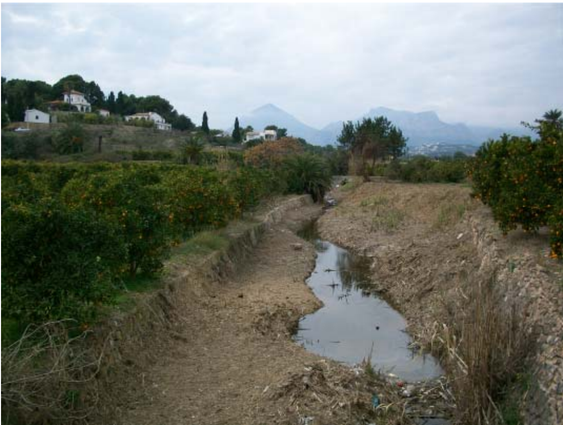
Vista del cauce aguas arriba de la rotonda de la N-332, después de las labores de limpieza del cauce
