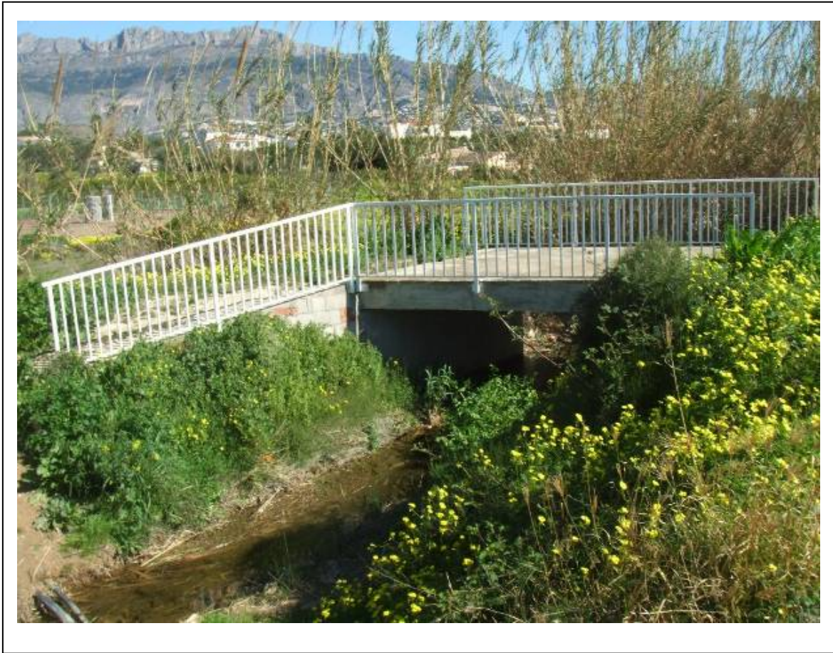
Pontón de paso en camino local de acceso privado. (ALT-303)
