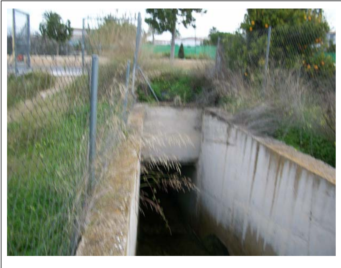
Vista de la acometida al colector en la A, Alcalde Juan Alvado. Paso denominado ALT -302
