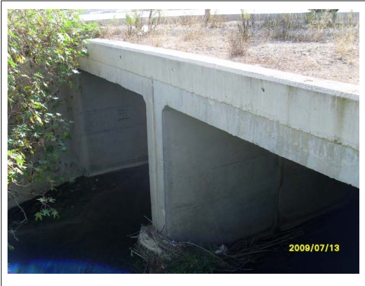
Paso ALT-203. Batería de marcos en camino local
