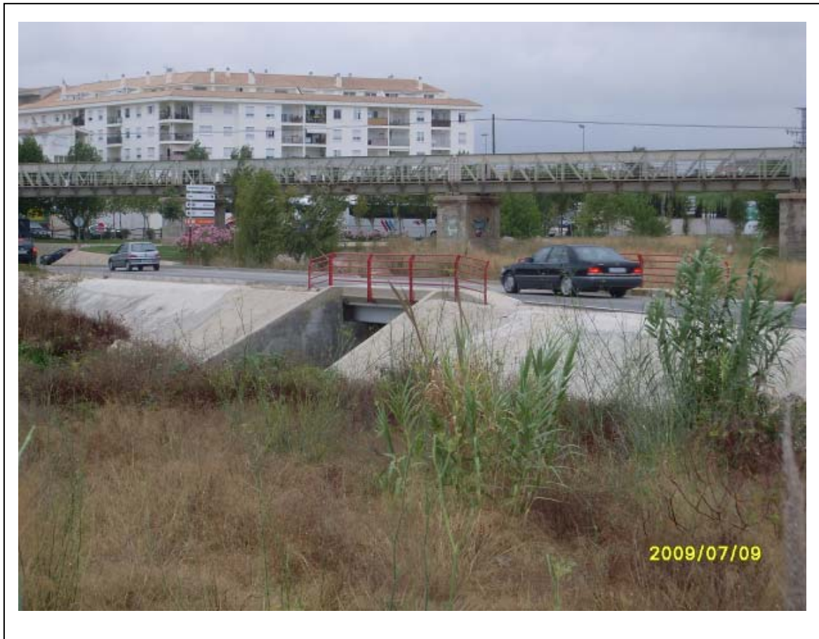
Paso denominado ALT-102. Badén inundable en camino local
