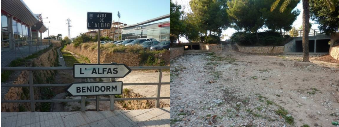
Canal Fondo, a la entrada de la rotonda de la Avda. de l'Albir.
