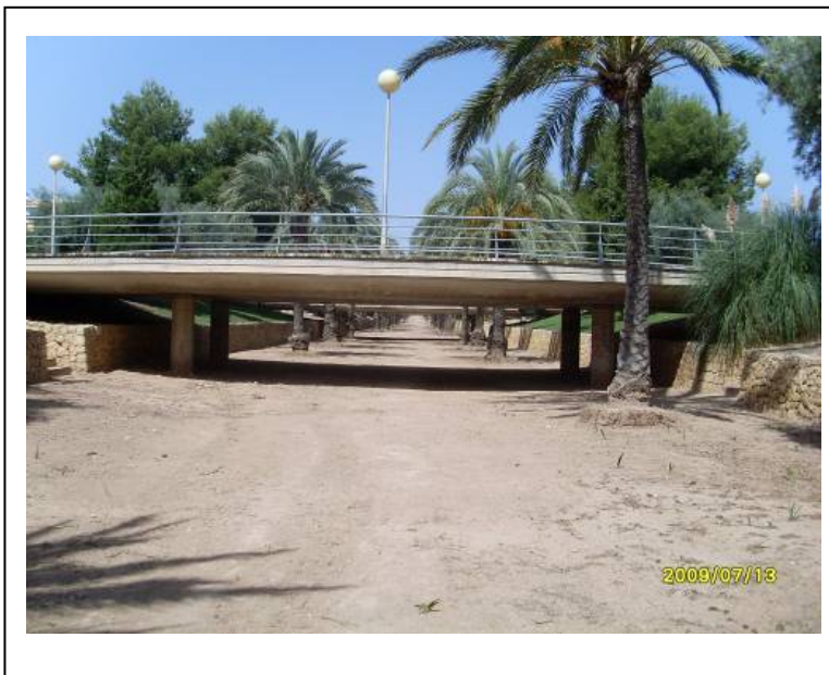
Vista de la obra de paso. ALF-117
