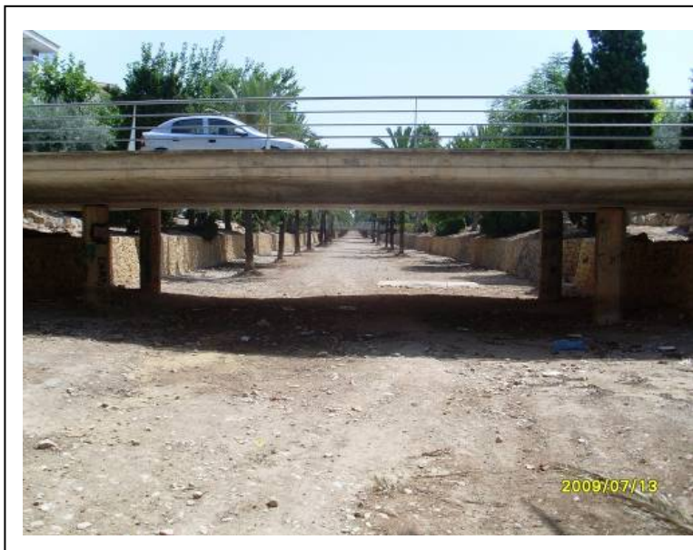
Vista de la obra de paso. ALF-116
