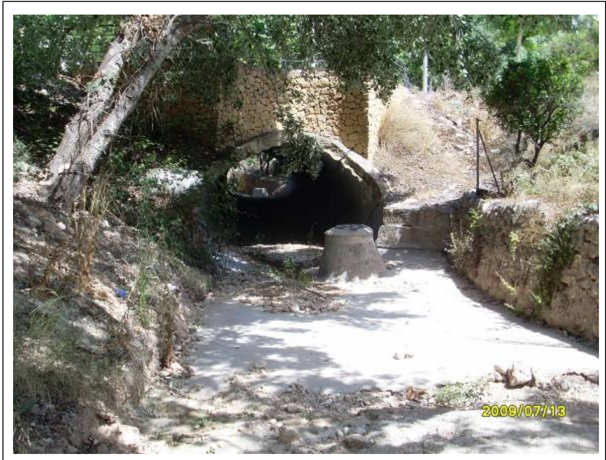
Vista de la obra de paso ALF-112 desde aguas abajo
