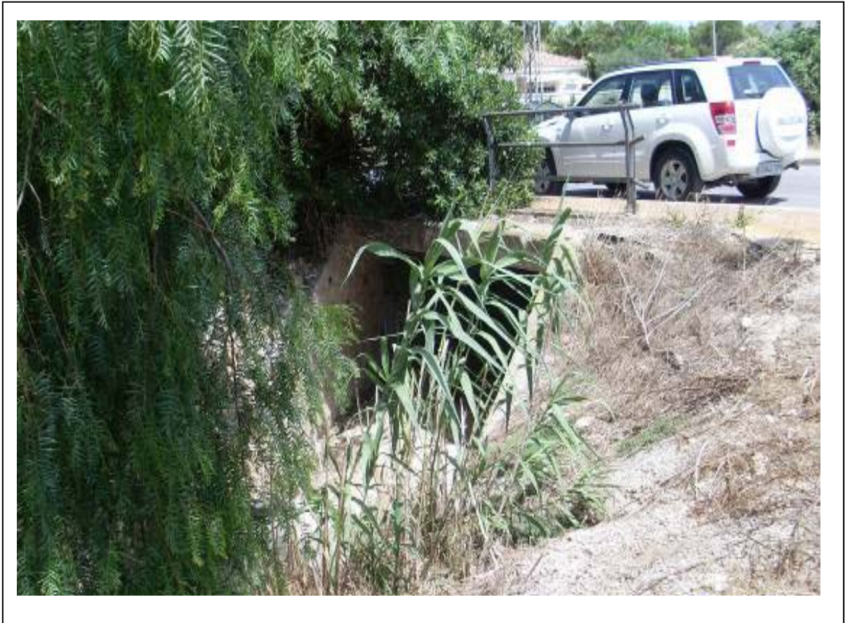
Vista de la obra de paso ALF-110 desde aguas abajo
