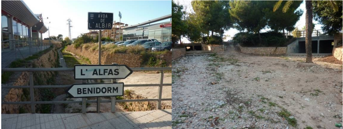
Canal Fondo, a la entrada de la rotonda de la Avda. de l'Albir.
