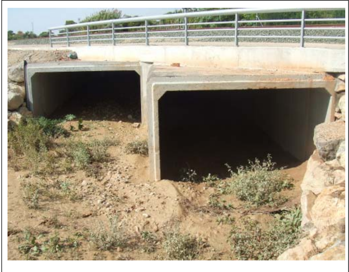
Vista de la obra de paso del ferrocarril Alicante – Denia, mediante dos marcos de 4.00x2.30 (dimensiones interiores) ALF-108
